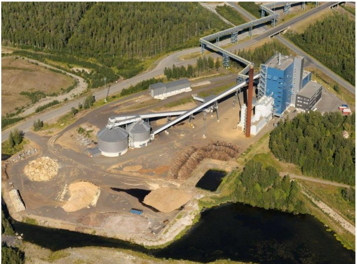
Kuva 1. Ilmakuva Tornion Voima Oy:n voimalaitoksesta Outokumpu Stainless Oy Tornion tehtaiden tehdasalueella. (Tornion Voima Oy 2015.)
