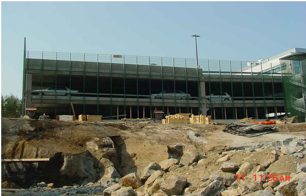
Kuva 1. Näkymä louhoksen pohjalta. Laajennus liittyy kiinteästi tähän.
