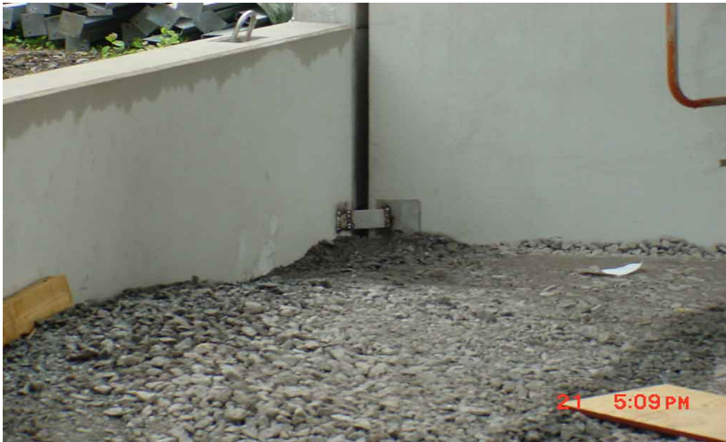
Kuva 12. Sokkelielementit kiinnitetään hitsaamalla.
