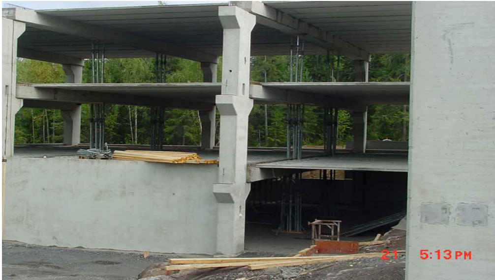
Kuva 13. Jäykistävä seinä paikallaan alimmassa kellarikerroksessa. Tavaroiden varastointipaikka kantavassa kohdassa seinän päällä.
