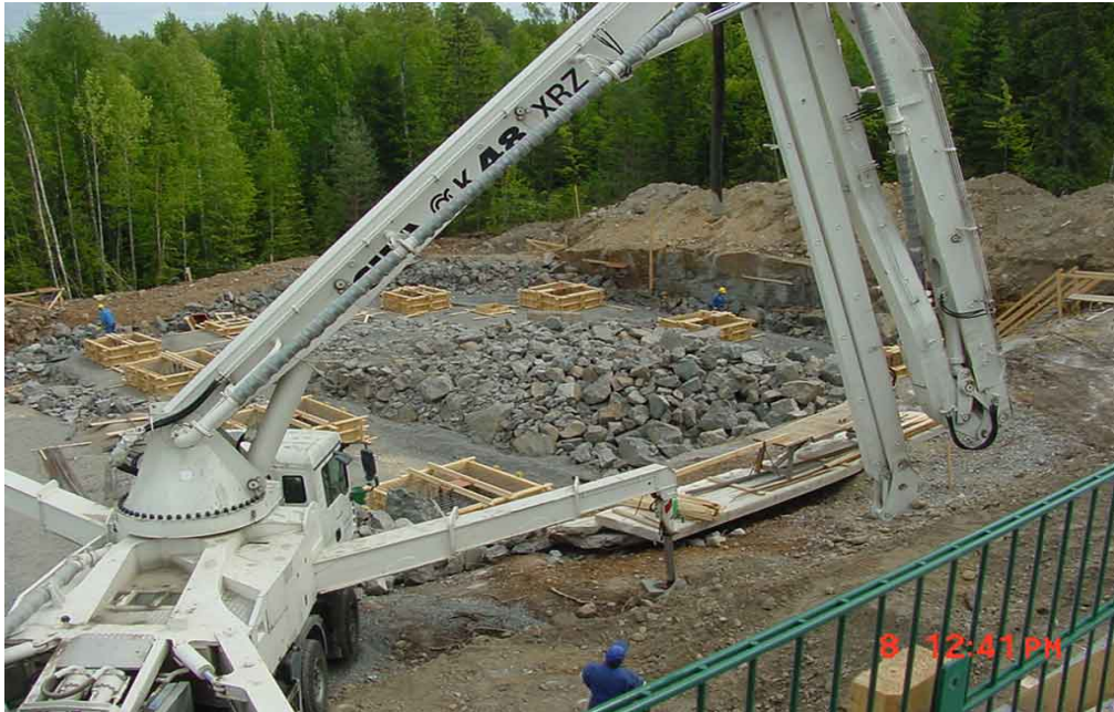
Kuva 3. Anturoiden betonointi suoritetaan tarvittavan järeällä kalustolla.
