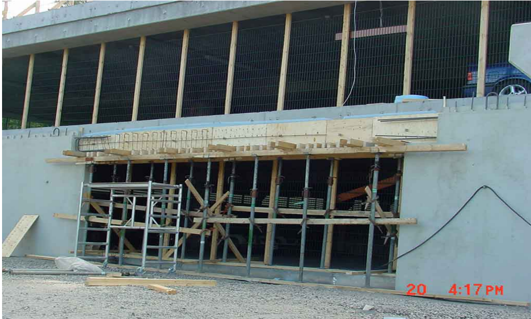
Kuva 16. Ylituspalkin muotitus ja raudoitus käynnissä.
