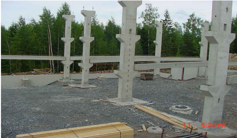
Kuva 4. Teräsbetonipilarit asennetaan peruspulttien varaan.
