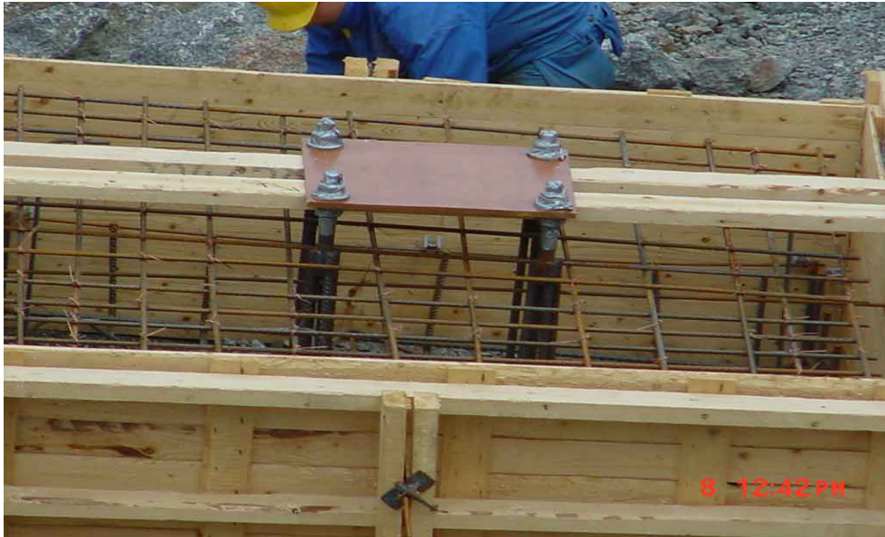
Kuva 2. Perustusvaihe. Pilarinanturoihin asennetaan pulttikehät ja varmistetaan etteivät ne pääse liikkumaan valun aikana. Kierteet suojataan roiskeilta.
