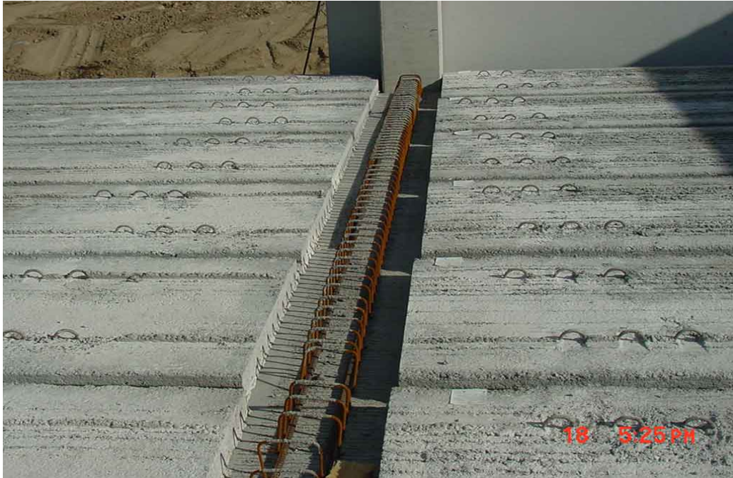
Kuva 8. Kuorilaatat asennetaan palkkien varaan.
