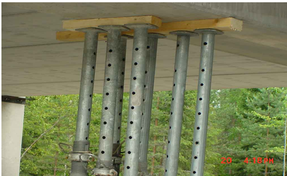
Kuva 7. Palkit tuetaan kolmannespisteistään laattojen asennuksen jälkeen.
