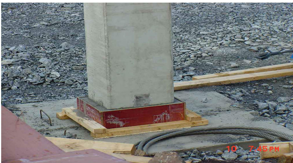
Kuva 5. Pilarien alapääät juotetaan paisuvalla juotosmassalla ennen palkkien asennusta
