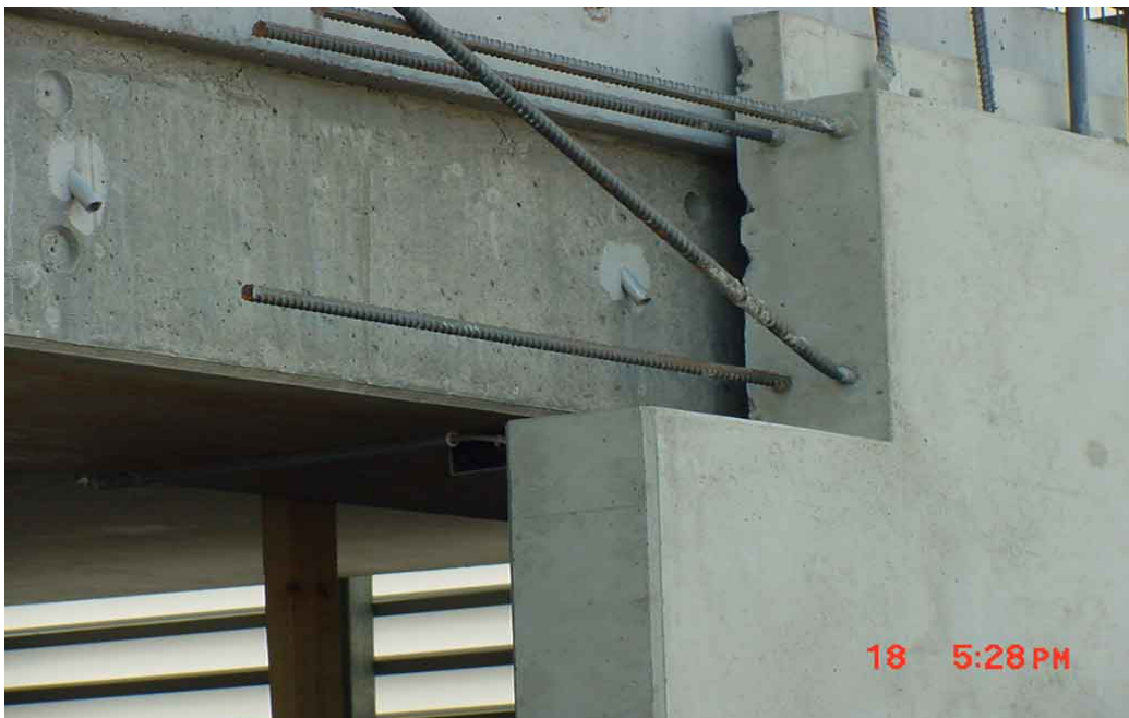
Kuva 17. Paikallavalupalkin järeät tartunnat seinäelementissä.
