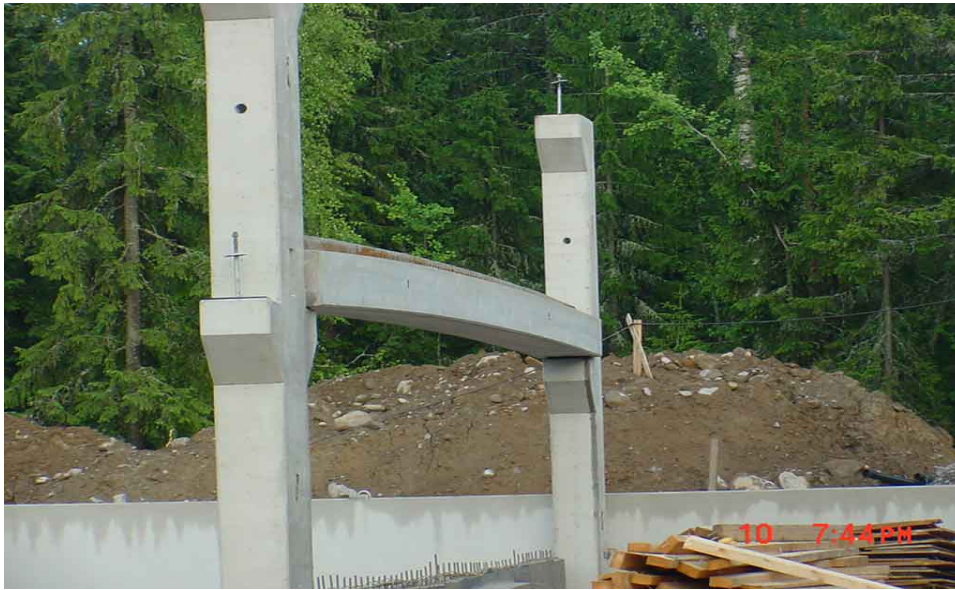
Kuva 6. Esijännitetyt palkit asennetaan pilarikonsolien varaan.
