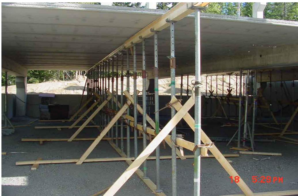
Kuva 9. Kuorilaattojen keskilinjän tuenta ennen valua.
