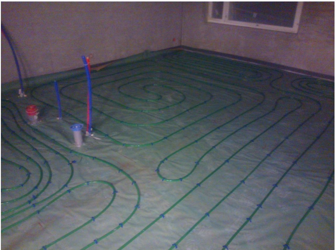
Kuva 4 Lämpölattian aluspaperi ja lämpöputket (YIT Rakennus Oy, Maarit Ovaska)
