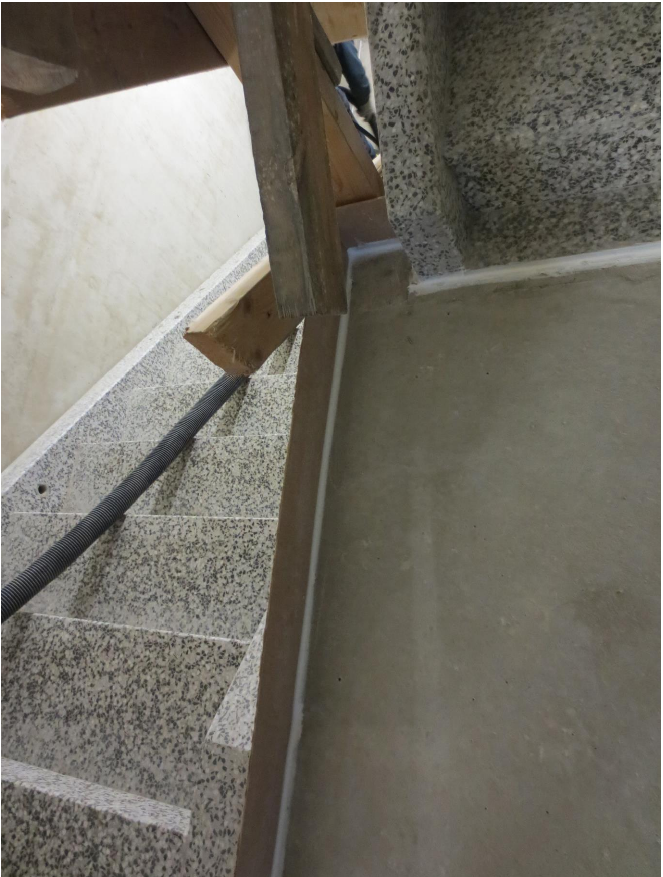
Kuva 11 Tasoitetukkeet estämässä tasoitteen valumista pois halutulta alueelta (YIT Rakennus Oy, Verner)
