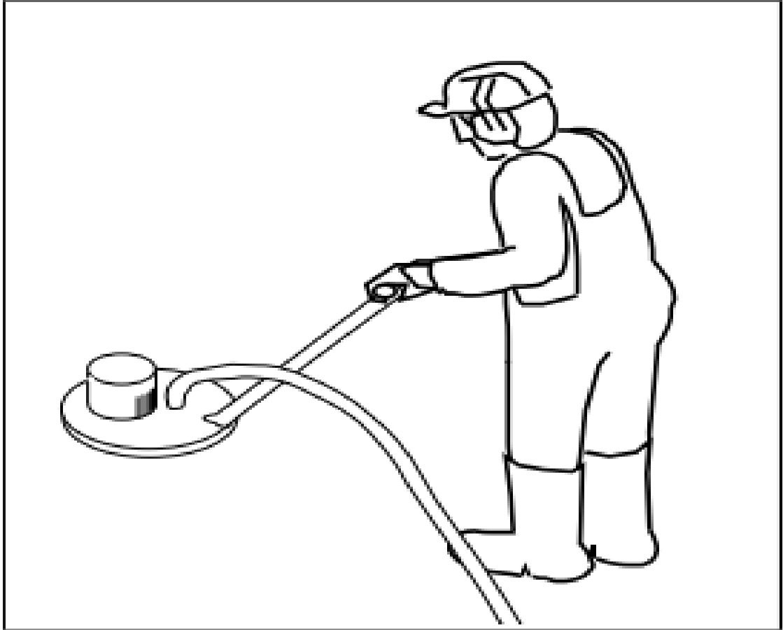
Kuva 13 Kovettuneen tasoitepinnan hionta lattiahiomakoneella (Ratu 0405)
