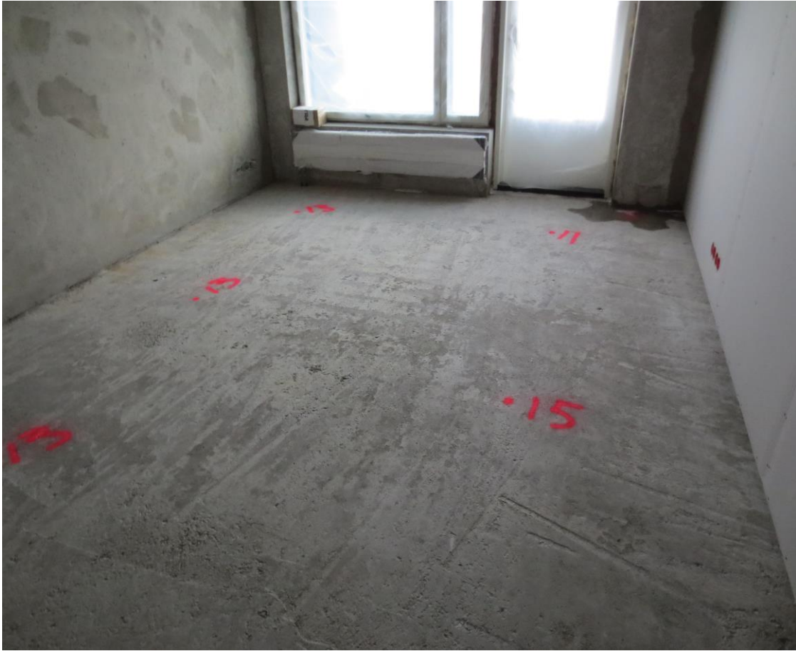
Kuva 10 Korkomerkkien asennus tasoitettavalle pinnalle (YIT Rakennus Oy, Verner)
