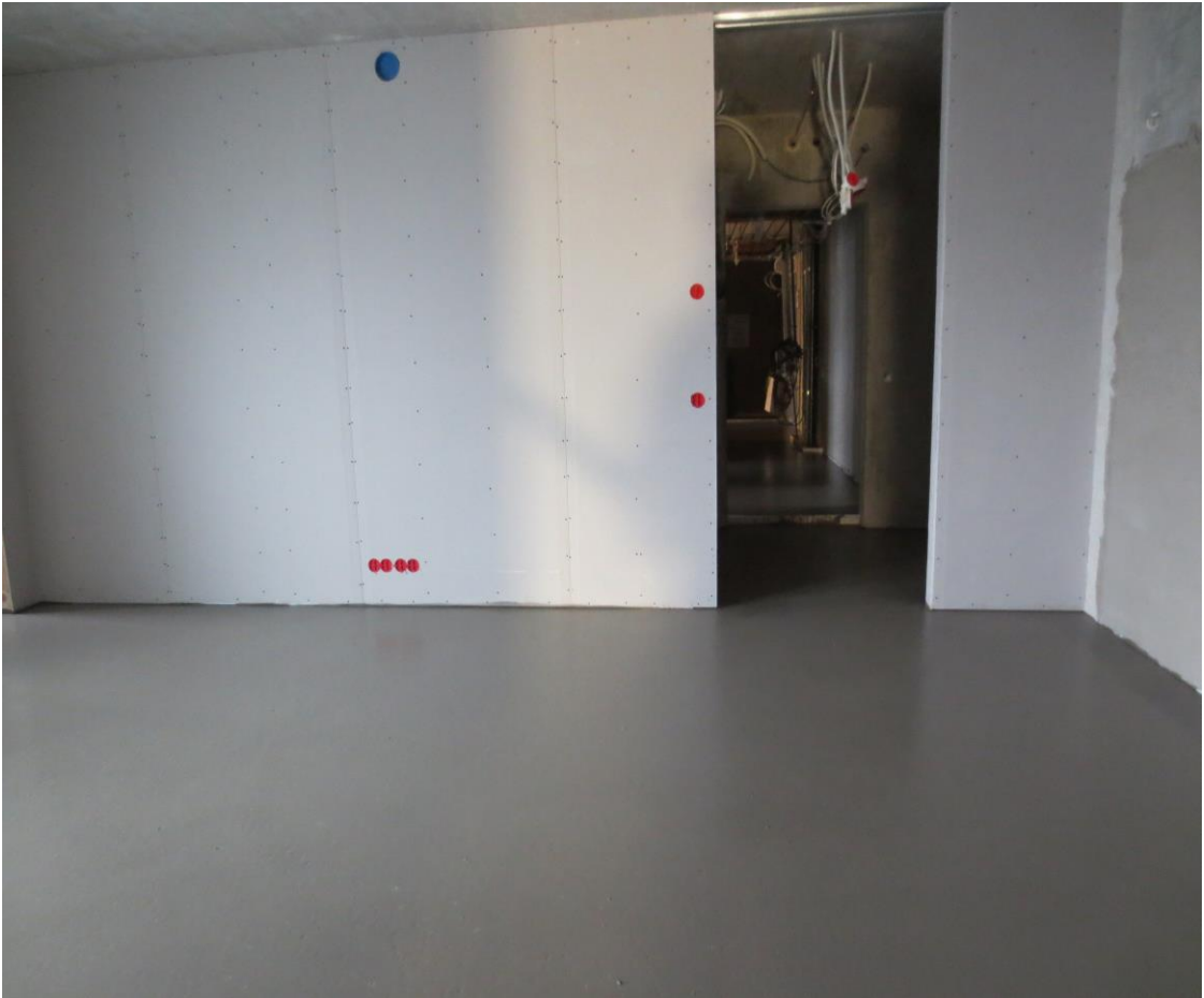
Kuva 12 Valmista tasoitelattia pintaa (YIT Rakennus Oy, Verner)
