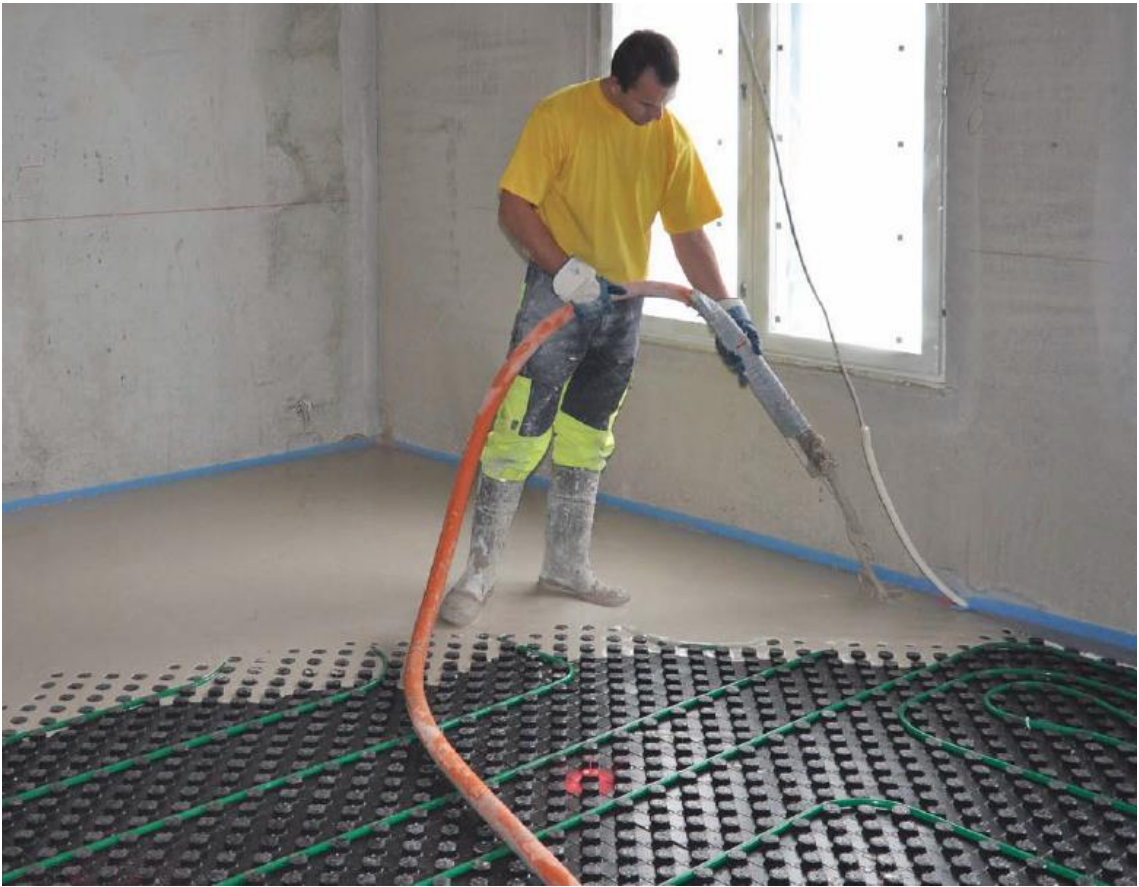
Kuva 5 Lattiatasoitteen levittämistä koneellisesti
