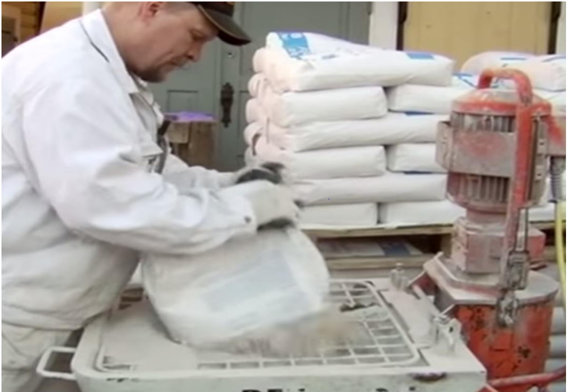
Kuva 3 Kipsitasoitteen sekoittamista (Knauf)
