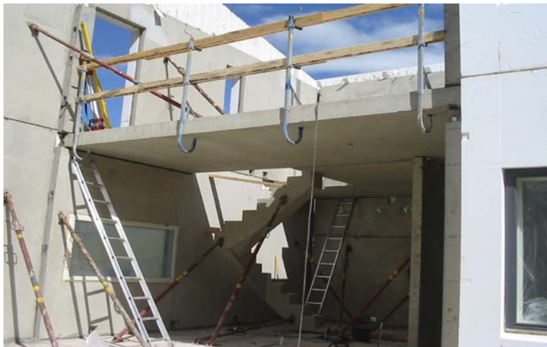
Kuva 16. Kuvassa on huolehdittu elementtien tukemisesta ja suojakaiteet ovat myös paikoillaan.
