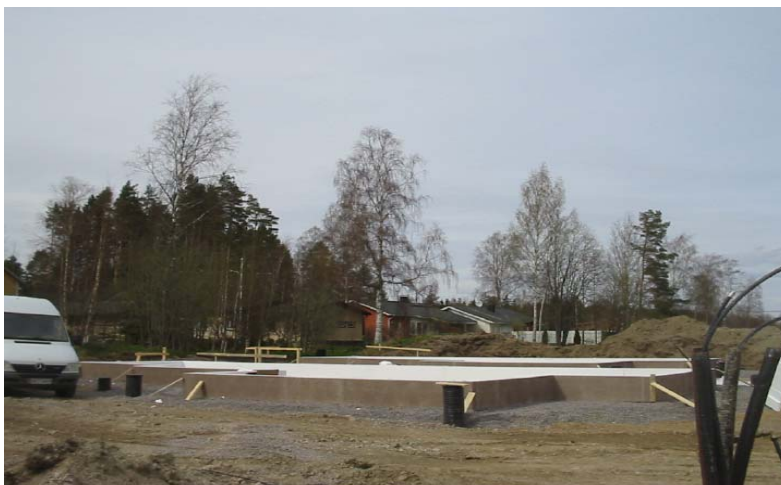
Kuva 15. Tässä kuvassa on huolehdittu heti salaojat, maanpinnan tasoitus ja täytöt kuntoon.
