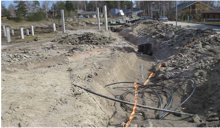
Kuva 14. Kuvassa on kaivannot kaivettu tarpeeksi leveällä kauhalla ja kaivannon reunit ovat viistetty.
