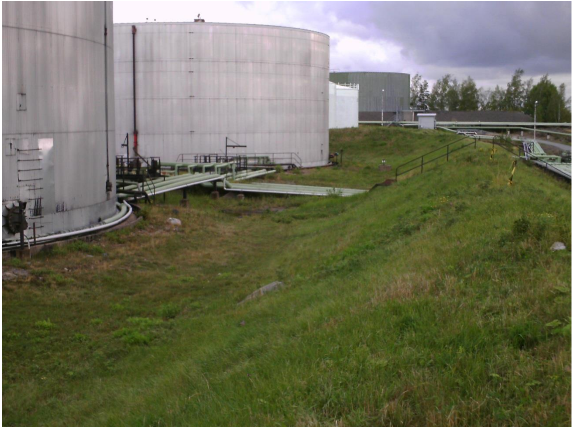
Kuva 9. Säiliöiden 57 ja 58 vallitila on pohjanmuodoltaan selvästi toista vallitilaa tasaisempi.
