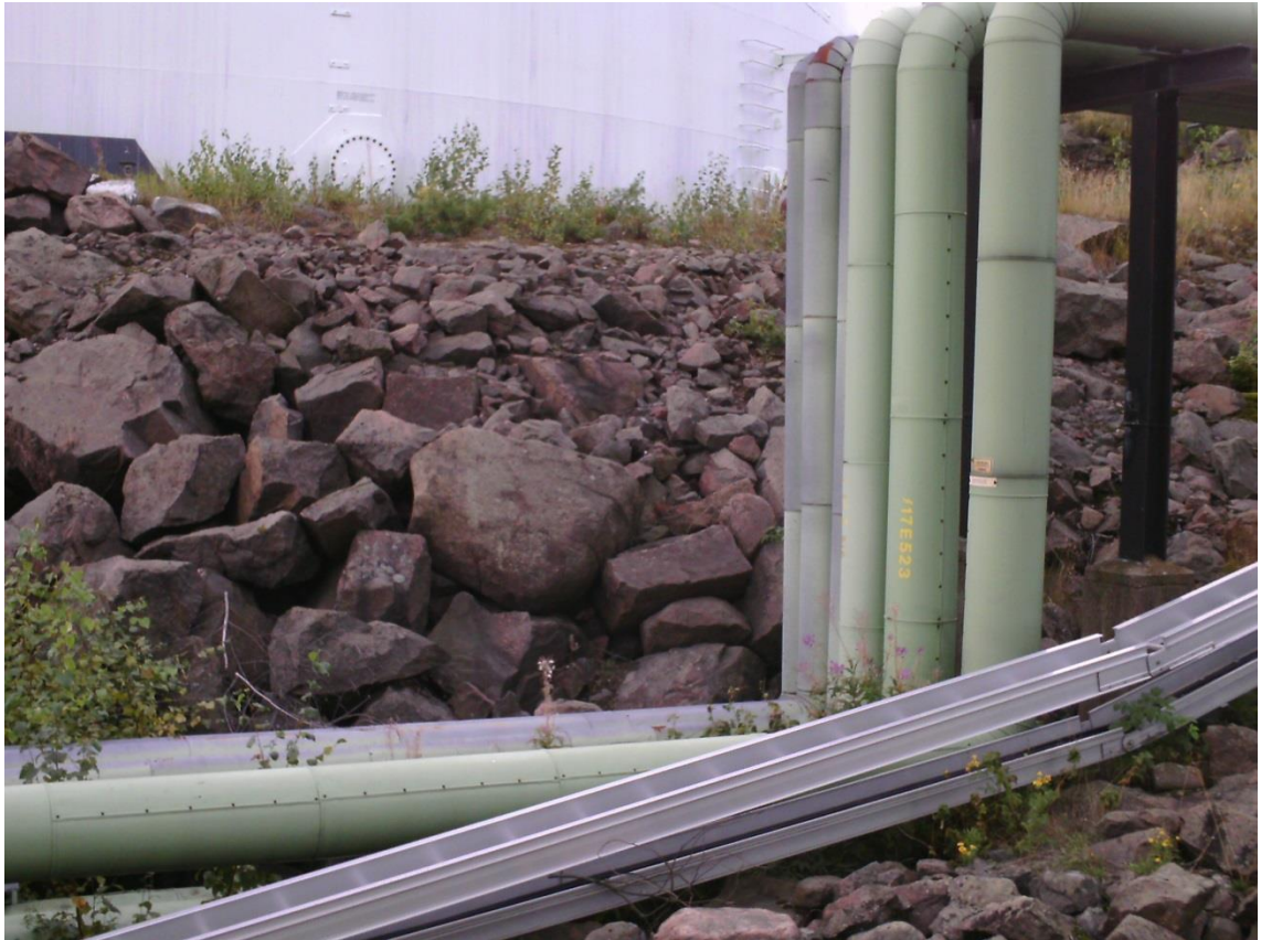
Kuva 4. Valtavien lohcareiden siirtämisestä putkilinjan alusmaan pinnoittamiseksi aiheutuisi liian suuri putkien vaurioitumisvaara.
