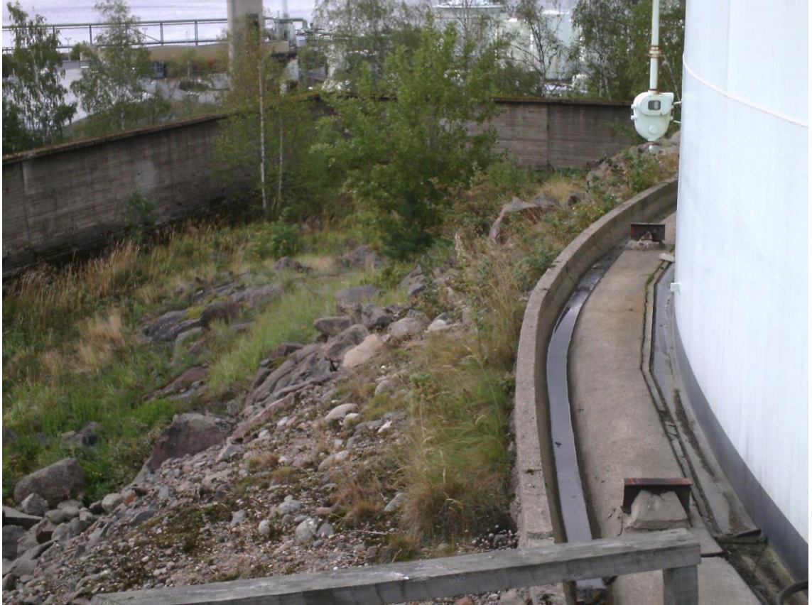
Kuva 6. Vanha säiliötä ympäröivä betoninen vesitys- ja sadevesikouru.
