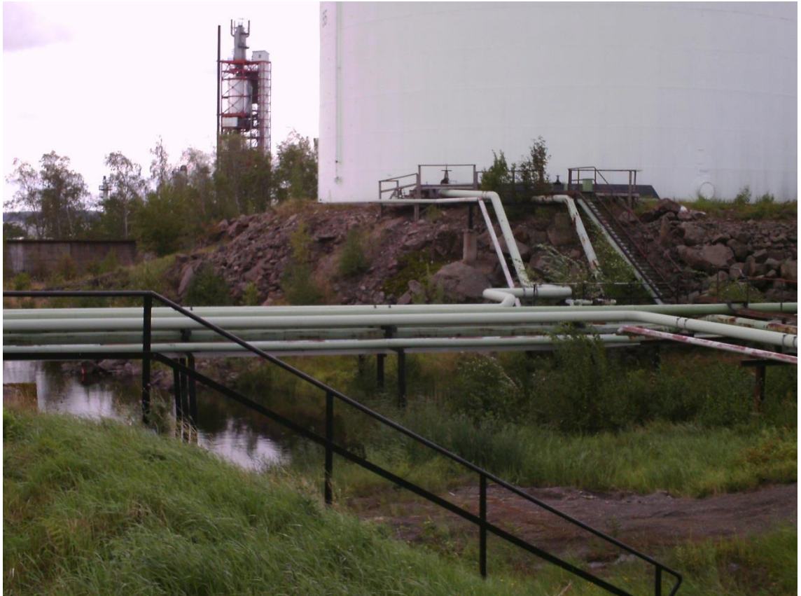
Kuva 8. Säiliö 55 lepää kivilouheen päällä. Louheluiska on paikoittain erittäin jyrkkä.
