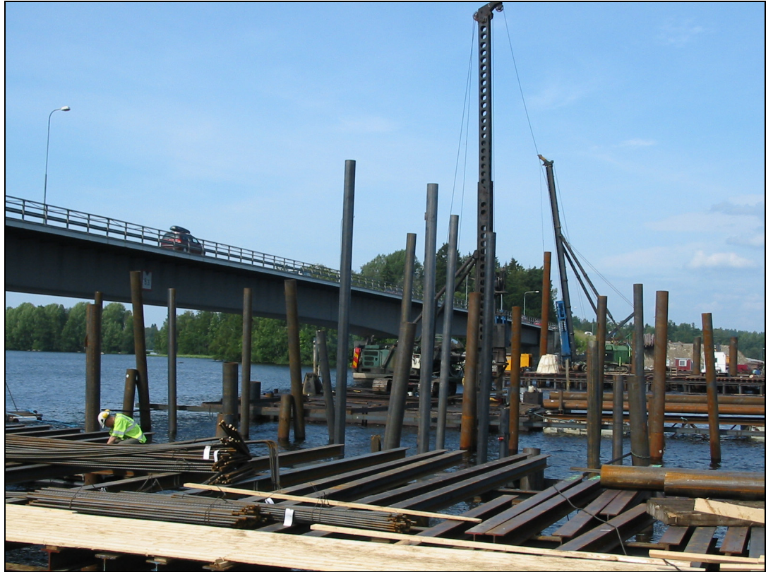
Kuva 18 Keskiaukon paalukot.
