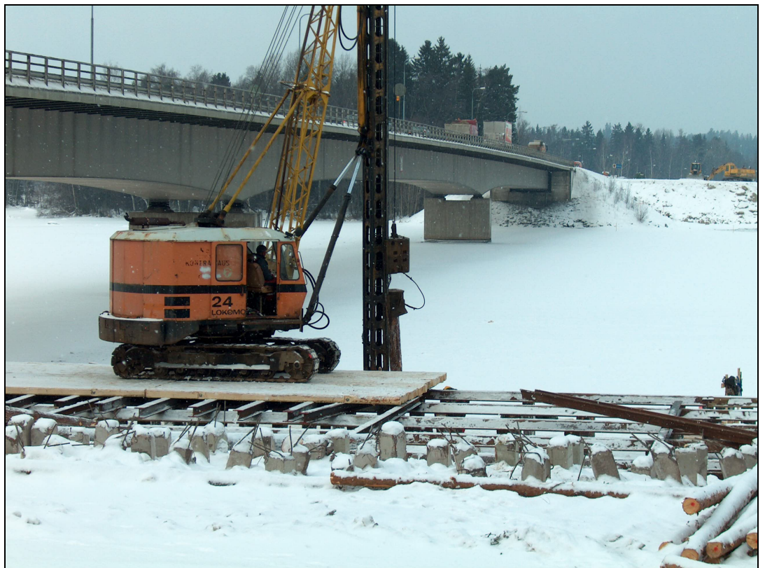
Kuva 15 Paalutustyö käynnissä tuella neljä tammikuussa 2004.
