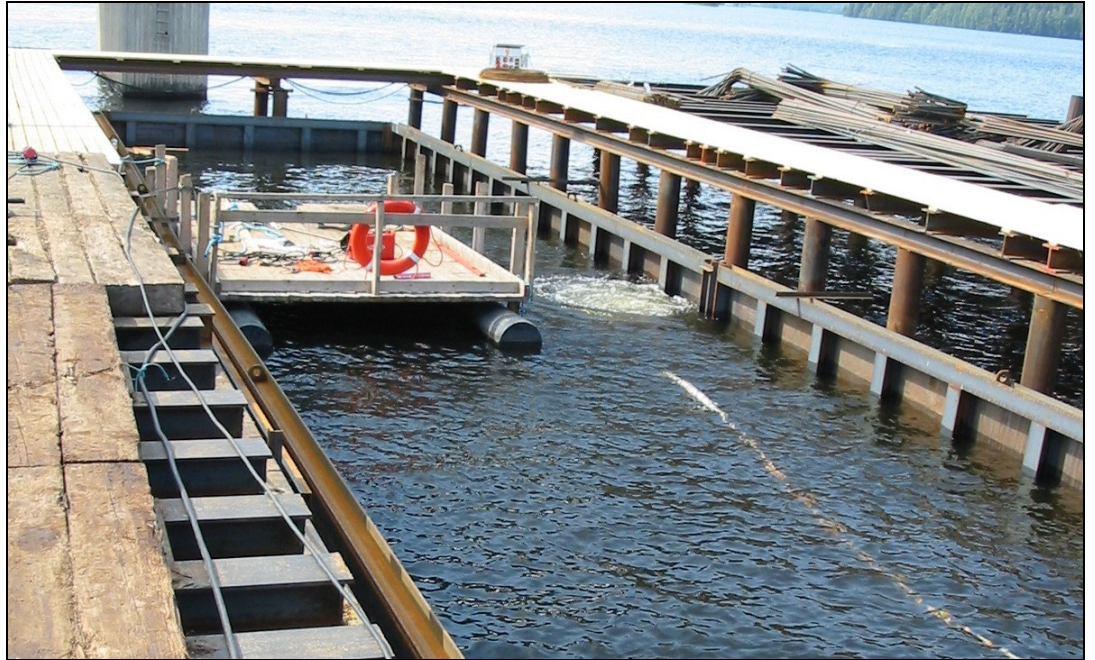
Kuva 17 Työsilta välituen kasuunimuotin ympärillä.
