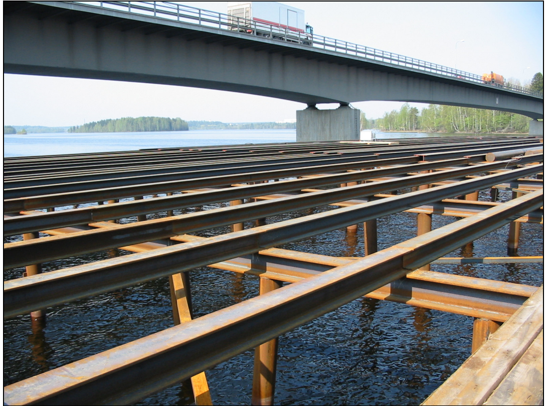
Kuva 11 Teräspalkkipaaluosuus Rajasaaren työsillassa.
