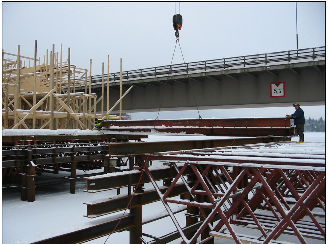
Kuva 14 Palkkien asennus kulkuaukon kohdalle.
