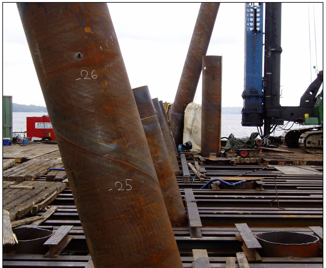
Kuva 16 Työsilta välituen paalujen ympärillä.
