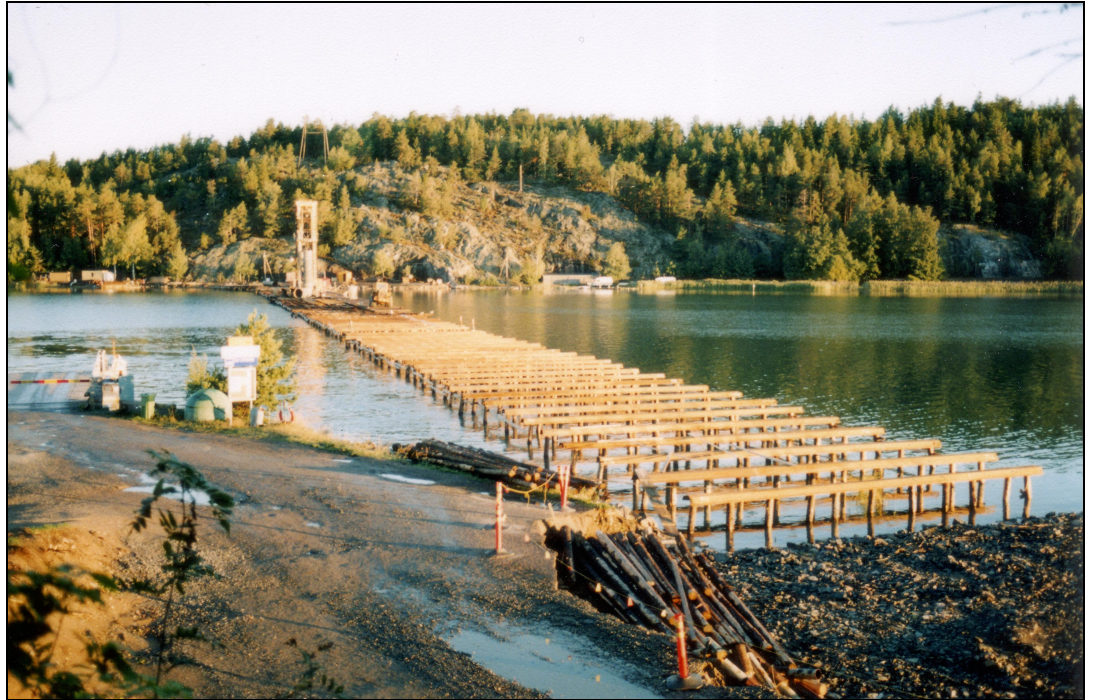
Kuva 6 Lautalta paalutettu Harvaluodon työsilta /2/.
