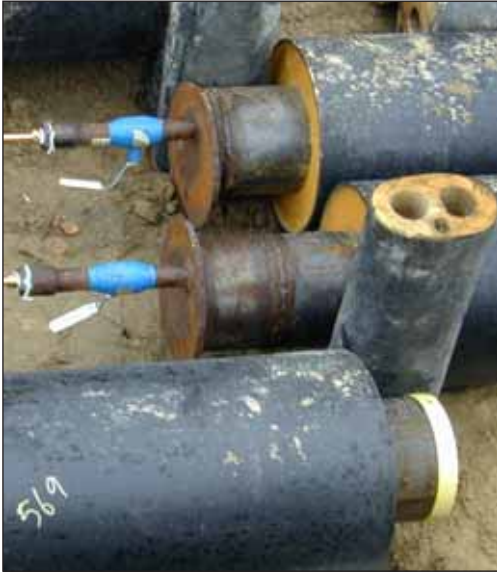
Kuva 39: 2Mpuk-kanavan valmistuneen osan loppupäähän asennettu lämmityskierto (venttiilit)
