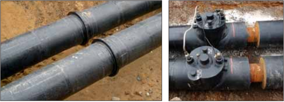
Kuva 35: Tehdasvalmiita kanavaelementtejä (kiintopiste ja venttiielementti)
