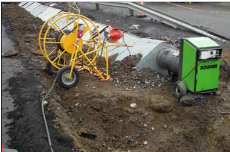
Kuva 80: Roudan sulatusta kaukolämpöverkon kaivantoa varten
