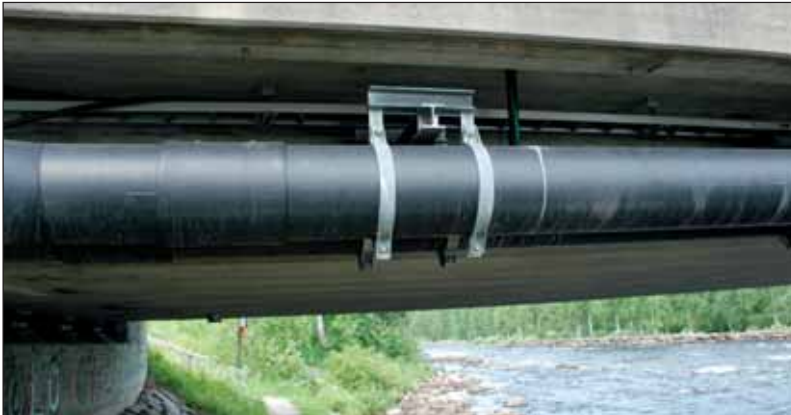
Kuva 69: Kaukolämpöputkien kannakointi sillan rakenteisiin
