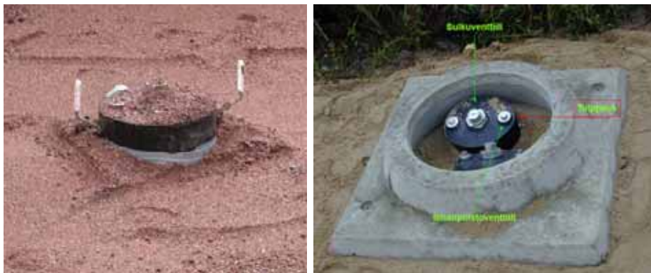
Kuva 81: Venttiilielementti asennettuna
