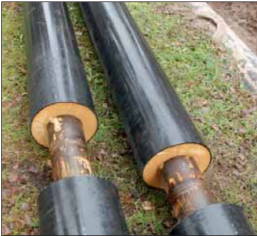
Kuva 34: 2Mpuk-elementtien jatkokset valmiina eristettäväksi
