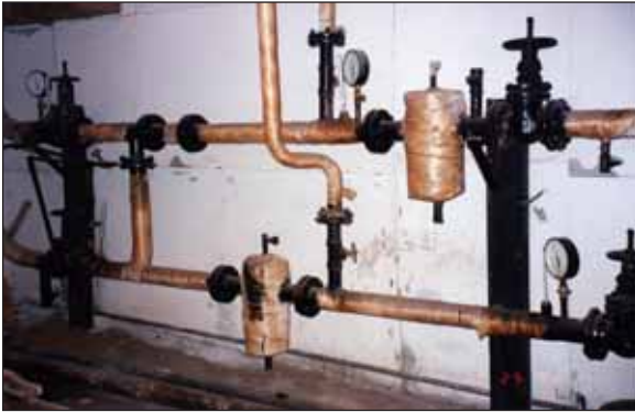
Kuva 95: Korttelilämmönjakokeskuksen lämmityspiiri suorassa kytkennässä (Pskov, Venäjä)
