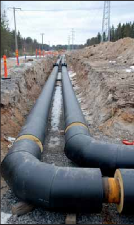
Kuva 31: Rakenteilla oleva kaukolämmön yhdysjohto
