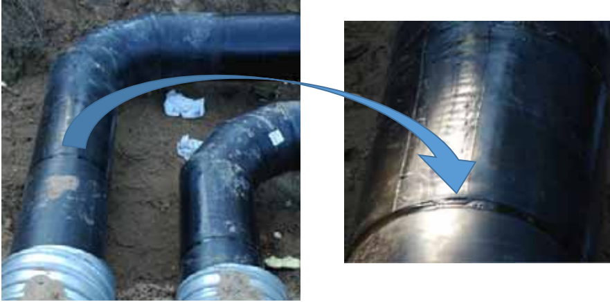
Kuva 74: Uuden kaukolämpöjohdon jatkos
