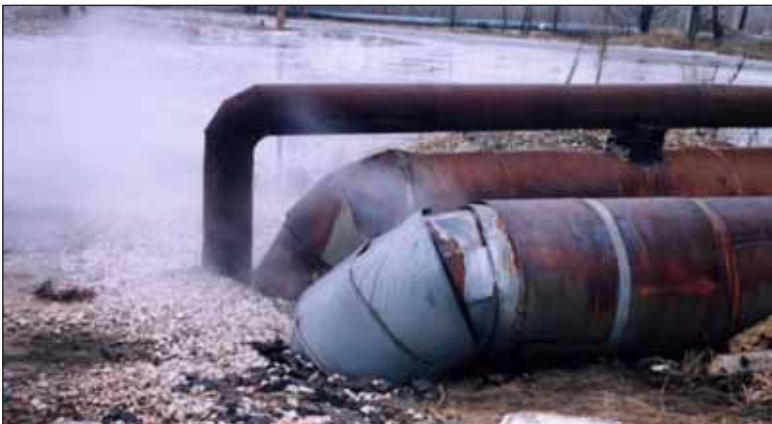
Kuva 71: Vesihöyry paljastaa vuodon (Nishni Novgorod, Venäjä)
