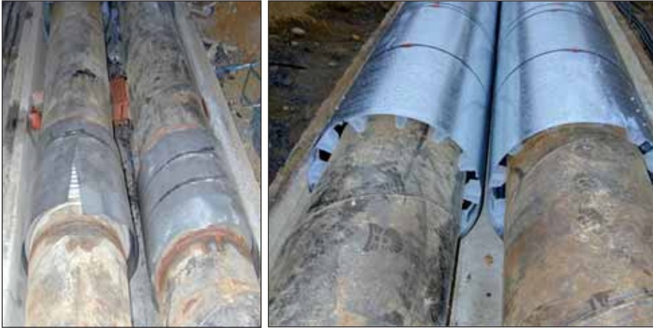
Kuva 36: Esimerkkejä betonielementtikanan saneerauksesta
