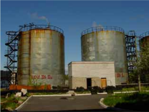
Kuva 93: Kaukolämpöveden varastosäiliöt (3x50 m 3 ) lämpimän käyttöveden huippukulutusta varten (Kronstadt, Venäjä)
