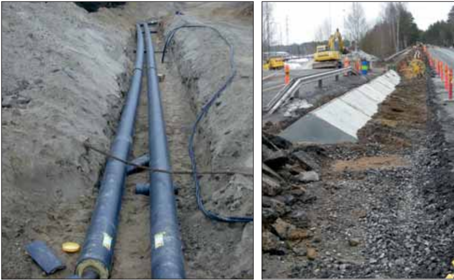
Kuva 37: Kaukolämpöverkosta rakenteilla
