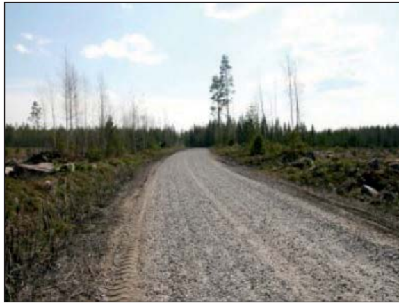
KUVA 6. Hyvässä kunnossa oleva varsitie, joka kestävä kesällä tapahtuvan puutavaran kuljetuksen (Kuva: Metsäteho 2008a)
