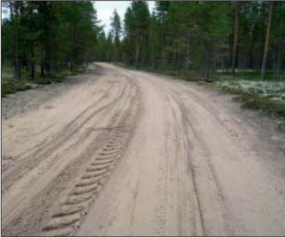
KUVA 8. Tie kestäisi maaperän puolesta myös kelirikon aikaisen kuljetuksen, mutta kulutuskerroksen hienojakoisuus estää puutavaran kuljetuksen ainakin sateisena aikana (Kuva: Metsäteho 2008a)
