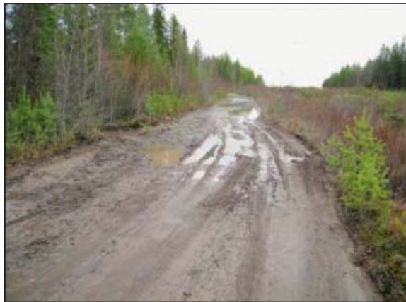
KUVA 7. Tie kestävä ehkä kesällä kuivaan aikaan tapahtuvan puutavaran kuljetuksen. Tämän näköisillä teillä kannattaa aina tarkistaa käänköpaikka (Kuva: Metsäteho 2008a)
