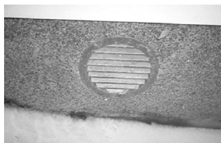
Kuva 20.2 Ryömintätilan ilmanvaihtoritilä
