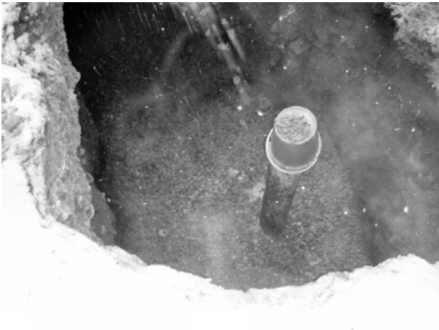
Kuva 17.9 Kaivoon asennettu putki
