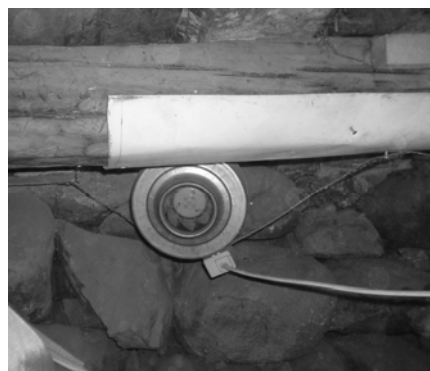
Kuva 19.4 Kanavapuhallin
