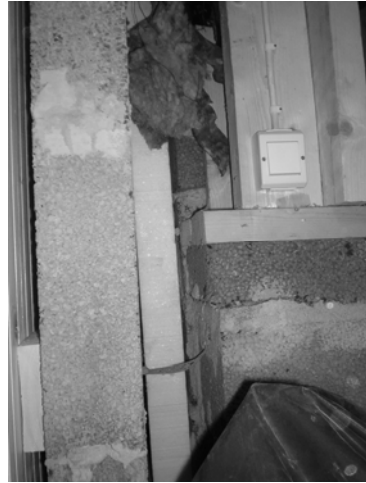
Kuva 11.1 Kellarin uusi seinärakenne
