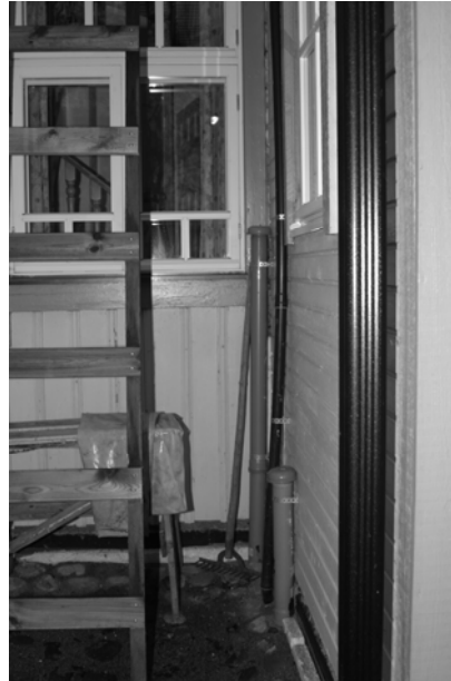
Kuva 12.3 Radon poistoputki
