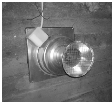
Kuva 20.3 Kanavapuhallin
