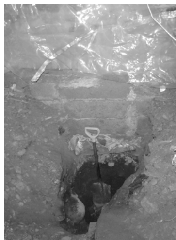
Kuva 17.5 Kellariin tehty kaivanto
