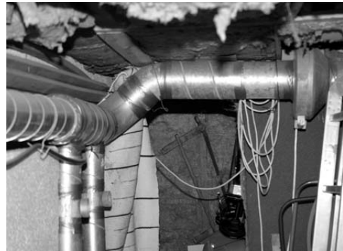
Kuva 16.6 Radonimuri toiminnassa
