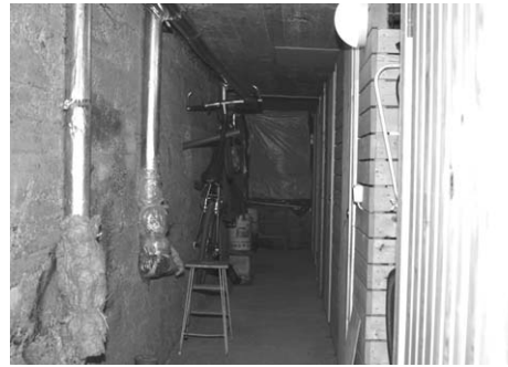
Kuva 10.3 Radonputkistoa
