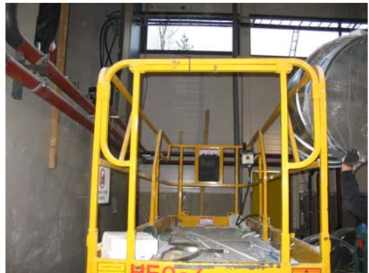
Kuva 2. Henkilönostimen portti teljety auki asentoon
