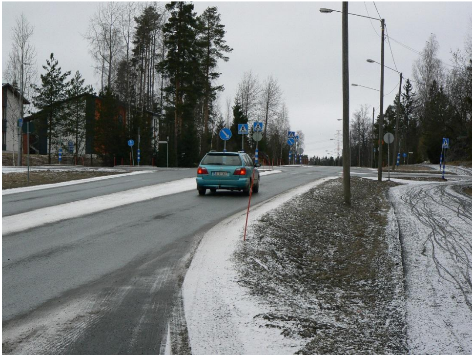
Kuva 4. Tutkimuspaikka etelästä päin kuvattuna ennen nopeusnäytön asennusta
