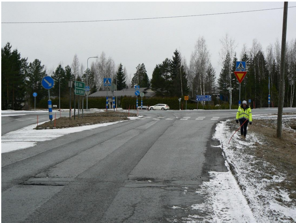
Kuva 7. Tutkimuspaikka idästä päin moottoritien Kuljun erkanemisväylältä kuvattuna
