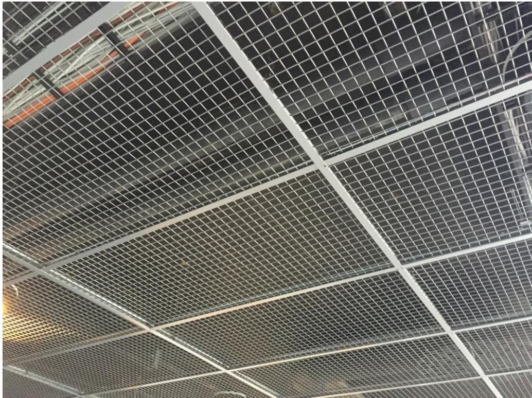
Kuva 13. Katossa kiinni olevat ritilät häiritsivät merkittävästi signaalia, jos iBeacon laitettiin niiden yläpuolelle
