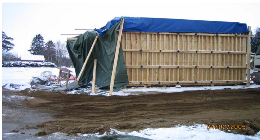
Kuva 1. Kuvassa on kuumabetonilla valettu ja suojattu puumuotti
