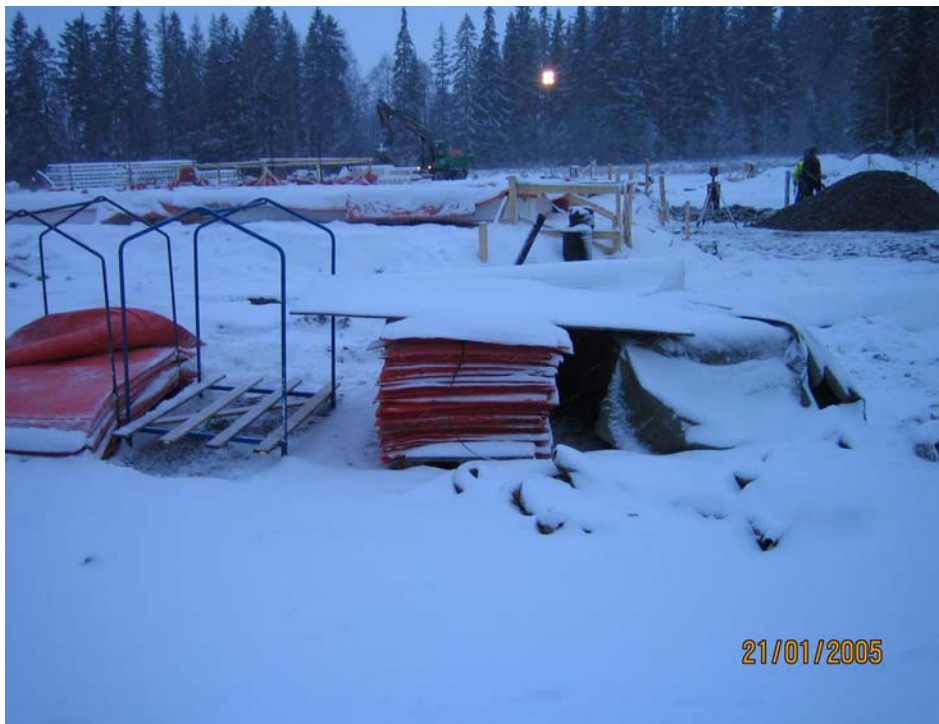
Kuva 7. Kuvassa on suojapeitteitä ja pakkasmattoja kuljetustelineissä.
