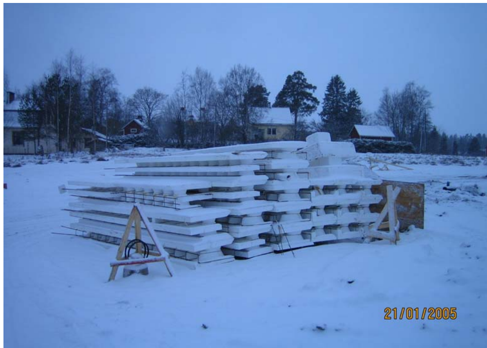
Kuva 5. Kuvassa on styroksista valmistettuja Soklex sokkelimuotteja, joissa rauditus valmiina.
