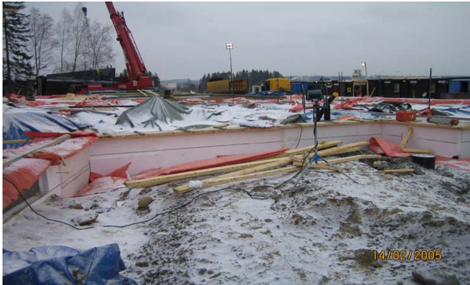
Kuva 6. Kuvassa on paikalleen asennettuja, valettuja ja suojattuja soklexmuotteja.
