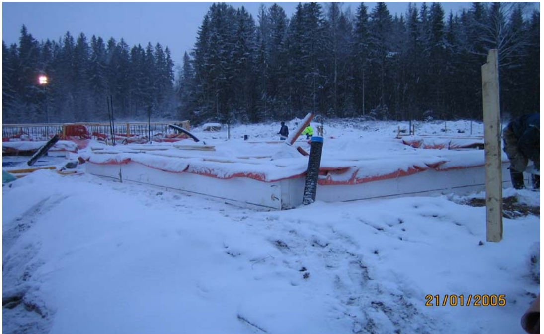
Kuva 2. Kuvassa on lämmöneristettyjä ja suojattuja perustusmuotteja
