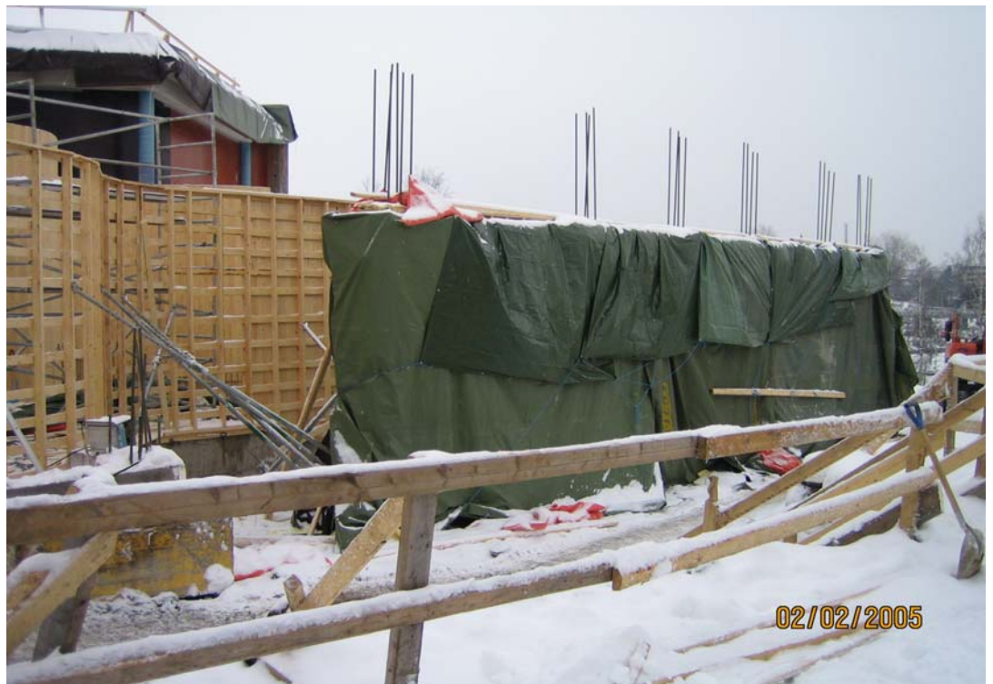
Kuva 3. Kuvassa huputettu seinämuotti, hupun alle on sijoitettu kuumailma puhallin.
