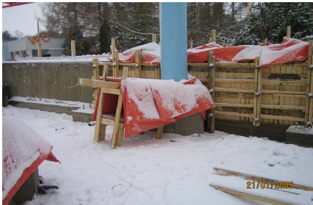
Kuva 4. Kuvassa on pilarin juotosvalua varten tehty suojahuppu. Lämmitys tapahtuu sähkökäyttöisellä kuumailmapuhaltimella.
