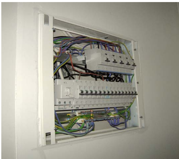
Kuva 8. Ryhmäkeskus peruskorjauksen jälkeen.
