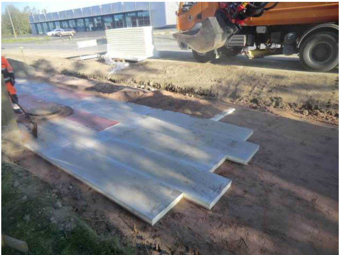
Kuva 2. Pitkittäin asennettuja Finnfoam INFRA -levyjä
