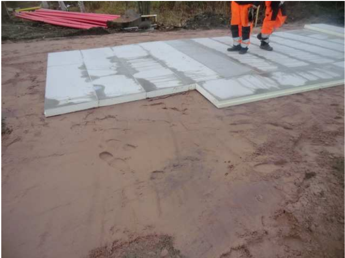
Kuva 3. Poikittaisladonnassa lisättiin yksi rivi myös pitkittäiseen suuntaan
