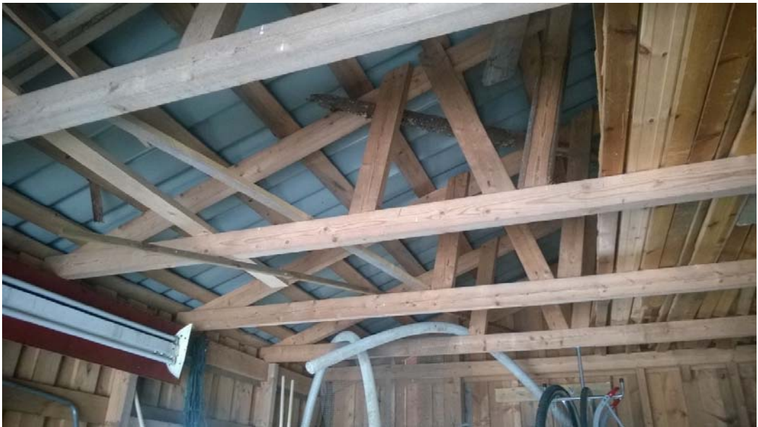
KUVA 11. Autotallin ristikko rakenne
