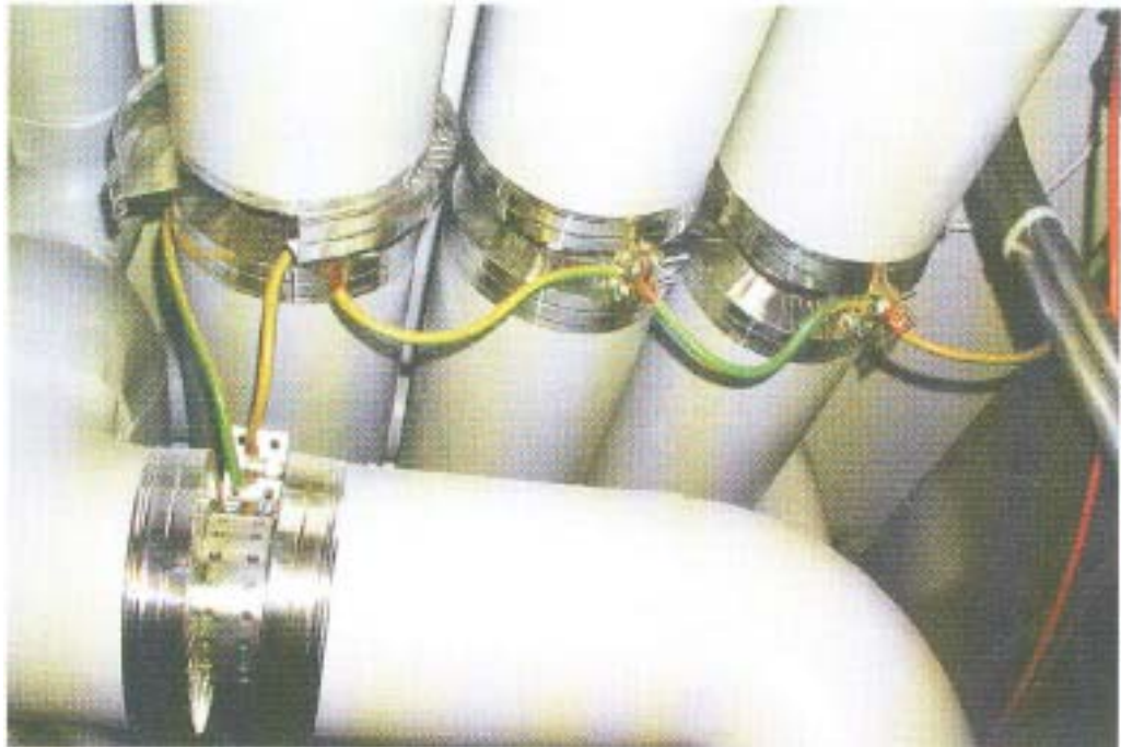
Kuvio 10 Lämpöputkistojen sarjamaadoitus. (Tiainen 2008, 71.)
