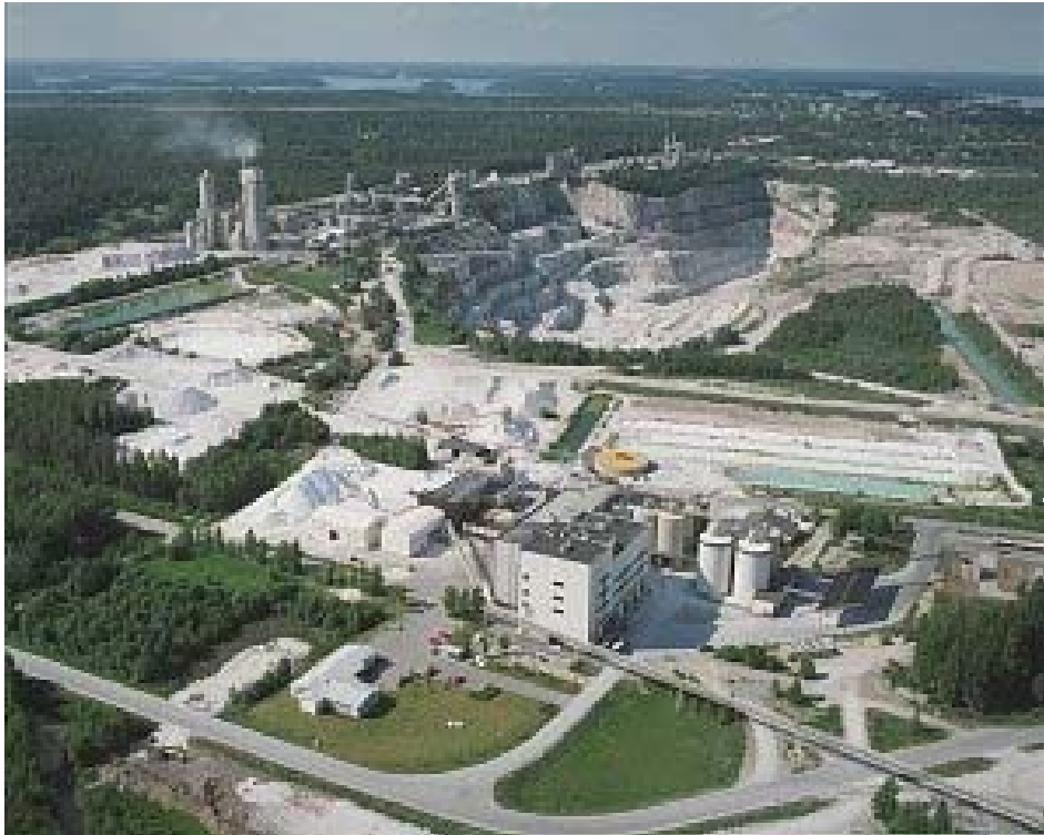
Kuva 1. ” Kuvassa etualalla Suomen Karbonaatti Oy:n rakennuksia. Avolouhoksen vasemmalla puolella erottuvat Finnsementti, Nordkalkin teknologiarakennus, kalkkitehdas, Paroc ja keskuskonttori.” /2/
