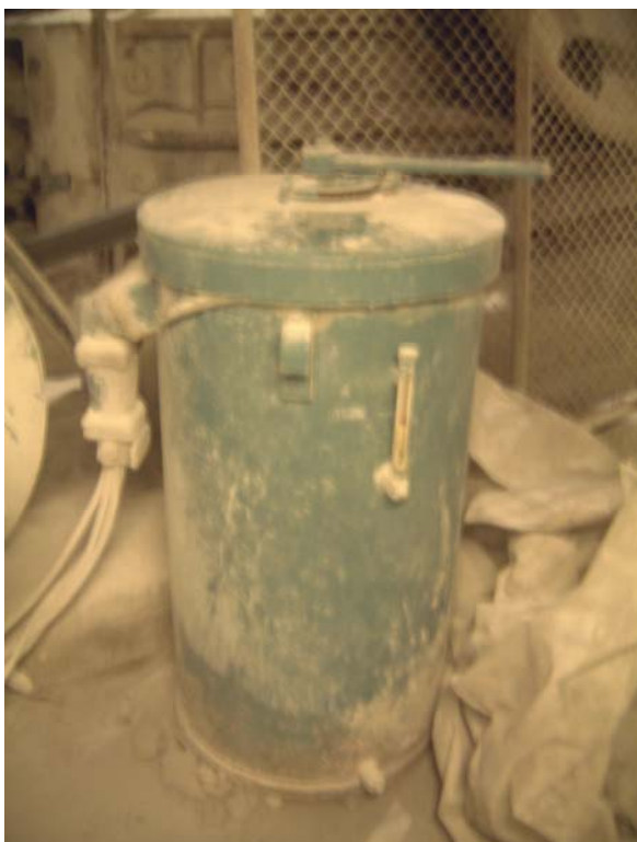
Kuva 3. Liukurengasmoottorin käsikäyttöinen käynnistysvastus
