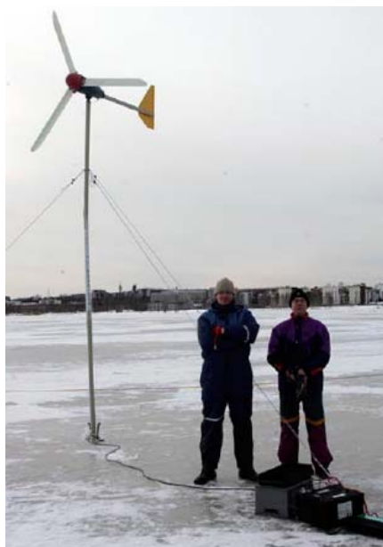
Kuva 4 Tuulivoimala WP200W asennettuna jäälle /17/
