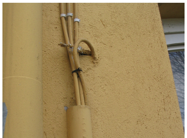
Kuva 28. Kaapeleita rappauksen sisään
