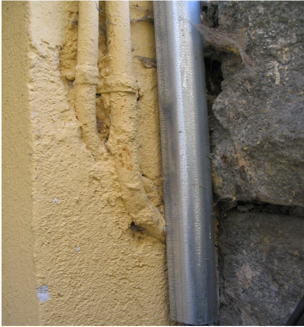
Kuva 29. Kaapeleita rappauksen sisään
