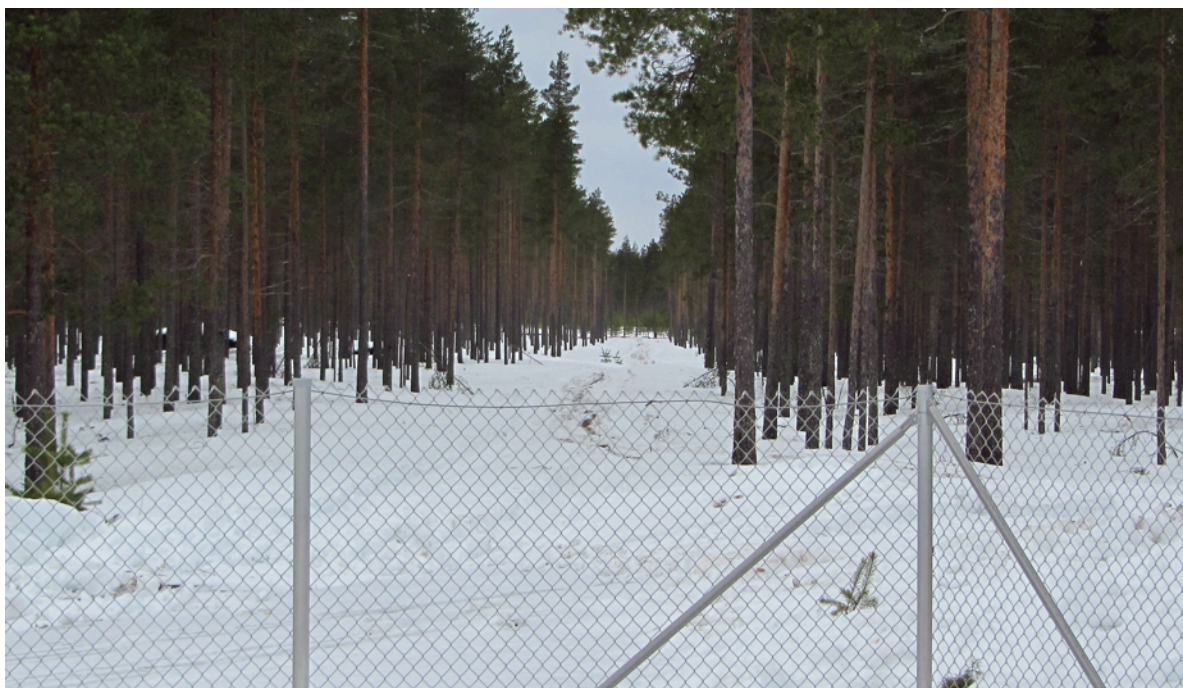
Kuva 6. Uusi-Someron hakkuuaukea, johon lähtevä runkovesijohto on kaivettu.
