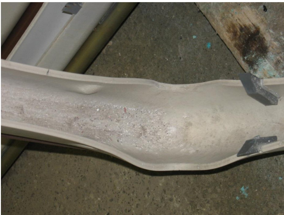
Kuva 4. Kourun alakulman pullistuminen.
