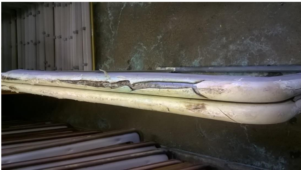
Kuva 5. Eristeen halkeaminen
