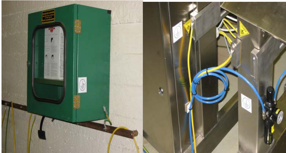
Kuva 8 Potentiaalintasausmittauspisteiden merkintä eri laitteissa.
