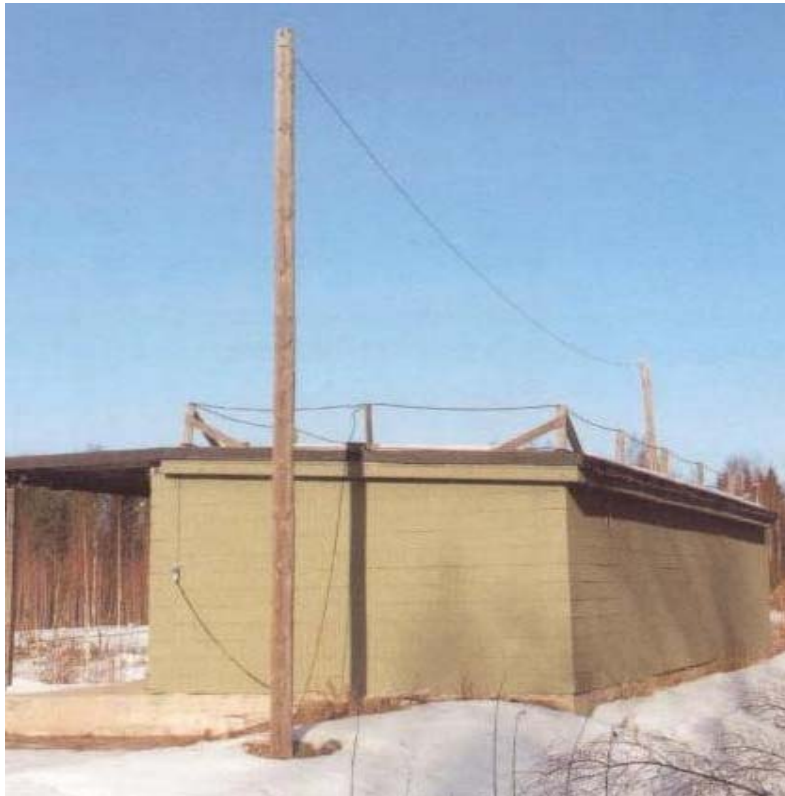
Kuva 13 Sähköistetyn varaston kaksinkertainen ukkossuojaus /21/
