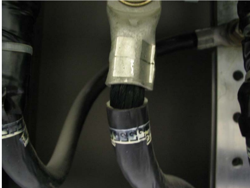
Kuva 24 Tummentunut liitos, pääkeskuksen PK etukojelähtö
