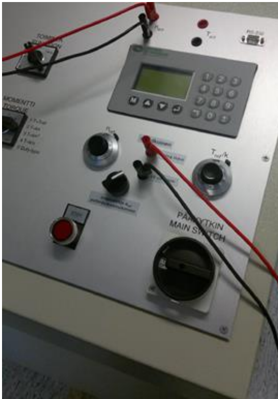
KUVA 8. Käyttöpaneeli kytkentämuutoksien jälkeen
