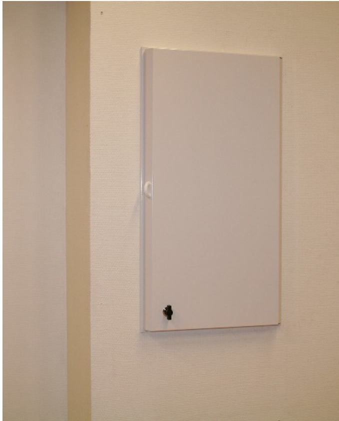
Kuva 7. Uusi valaistuksen ohjauskeskus
