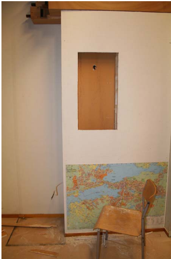
Kuva 4. Valaistuksen ohjauskeskuksen asennusaukko
