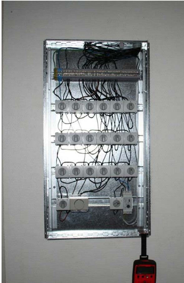
Kuva 5. Valaistuksen ohjauskeskus kytkettynä
