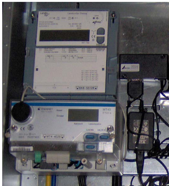
Kuva 24 Enermet MT40-mittapäätte (alla) sekä Landis & Gyr 6K6-55128 GSM-modeemi (päällä)
