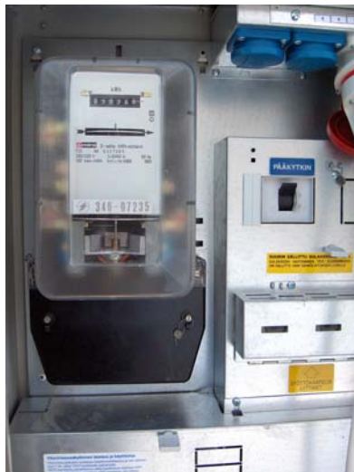
Kuva 15 Kolmivaiheinen induktioimittari(Mira T3C) sekä kWh-mittarin rakenneperiaate /43/
