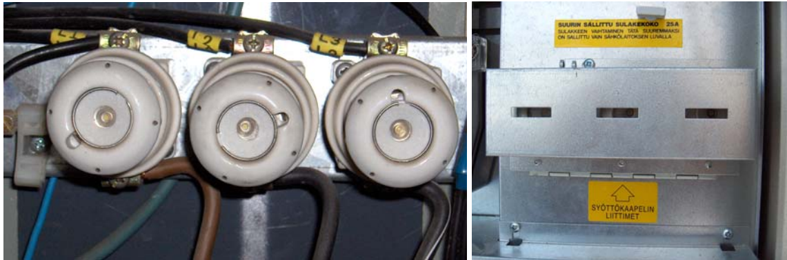
Kuva 12 25A:n pääsulakkeet ja päävarokekotelo
