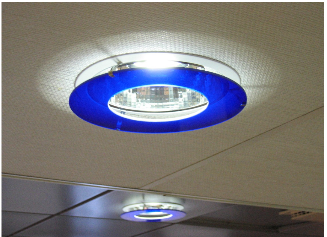
Kuva 13 Vastaanottotiskin takana katon kohdevalot
