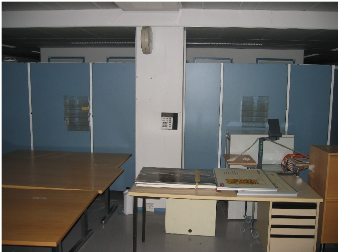
Kuva 6 Vastaanottotila ennen saneerausta
