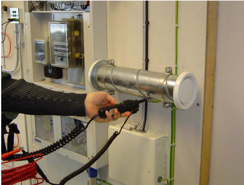
Kuva 26. Suojajohtimen jatkuvuusmittaus ilmastointikanavasta
