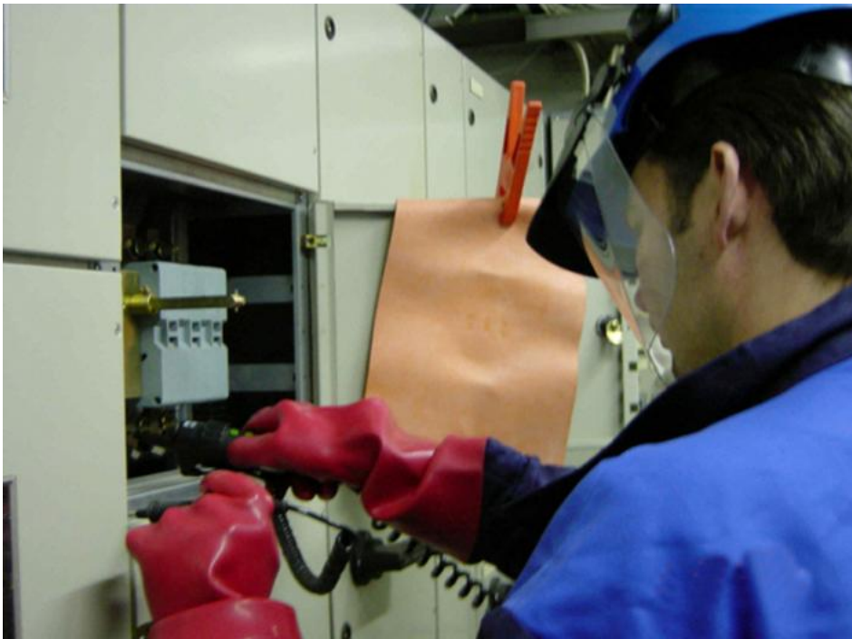
Kuva 13. Suurin oikosulkuvirta on syytä mitata pääkeskuksesta. Tällä mittauksella selvitetään, ovatko asennuksen kojeet riittävän oikosulkukestoisia. /5/
