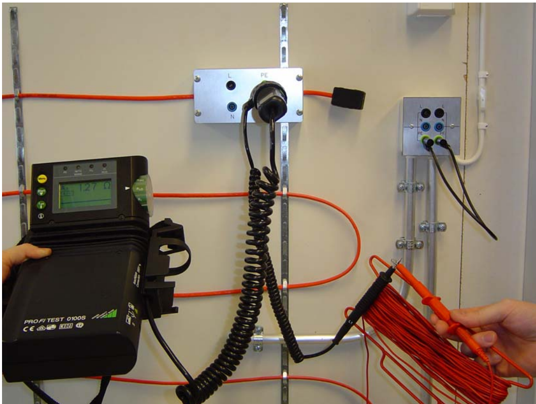
Kuva 27. Lämmityskaapelin suojajohtimen mittaus.
