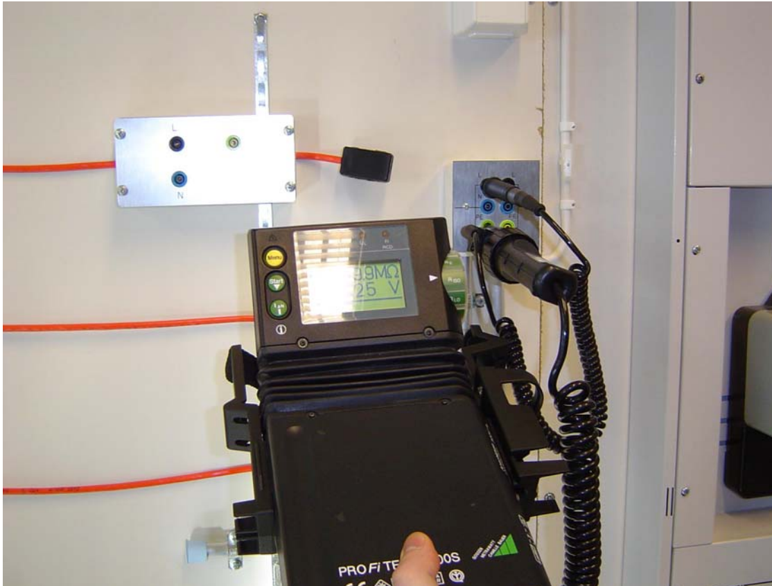
Kuva 22. Eristysresistanssin mittaus lämmityskaapelista
