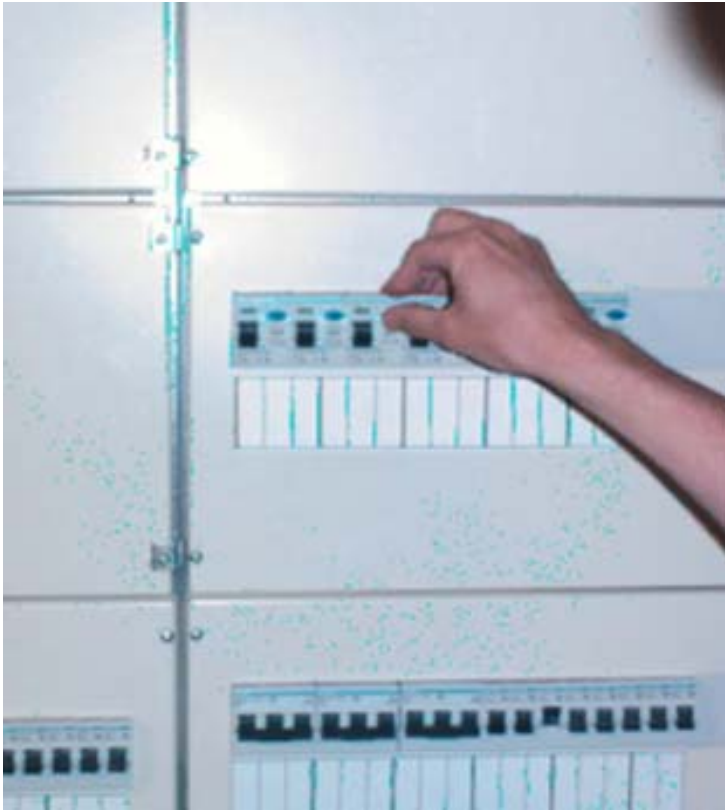
Kuva 14. Vikavirtasuojajkytkimen toiminta koestetaan ensin testipainikkeesta. /5/
