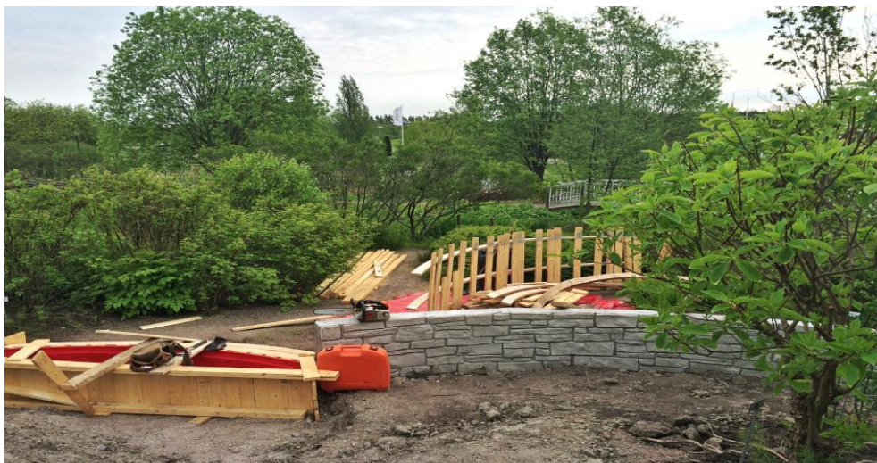
Kuva 7. Rakennusvaiheessa oleva sekä valmis kaareva tukimuuri. (Kokko, 2015).
