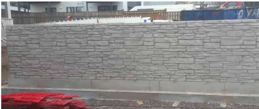
Kuva 9. Kuviobetonoitu, paikalla valettu muuri (Seppänen, 2015).
