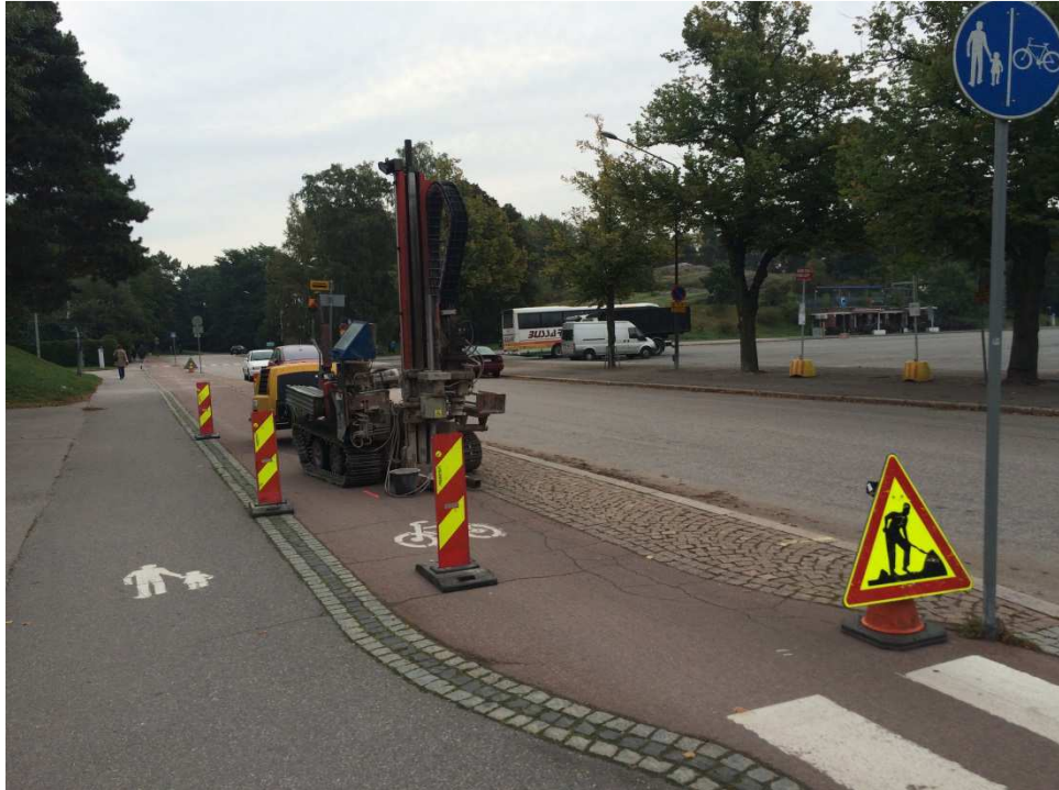
Kuva 15. Kairaustyö Mäntymäentien kevyen liikenteen väylällä Olympiastadionin läheisyydessä.
