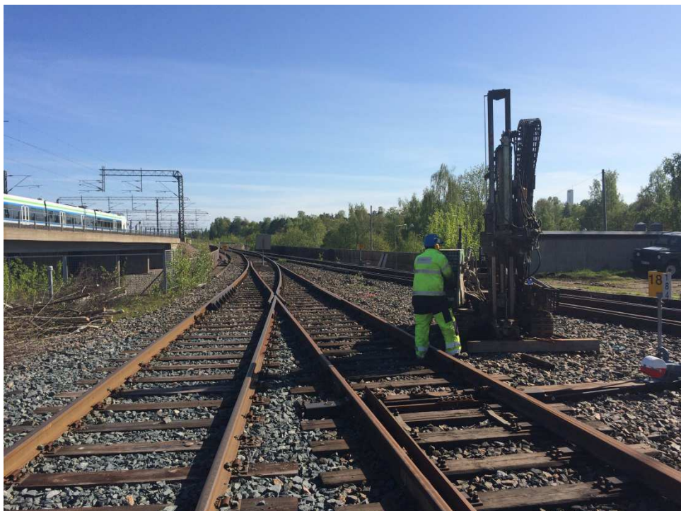
Kuva 9. Kairaus käynnissä ratapihalla.
