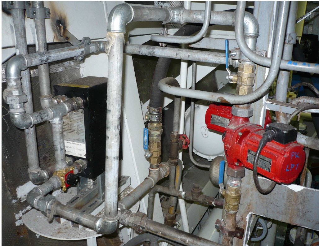
Kuva 8. Pääkoneen esilämmitin vasemmalla ja kiertovesipumppu edessä oikealla
