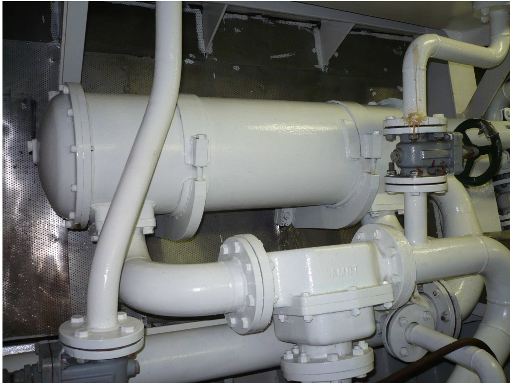
Kuva 4. SW/HT lämmönvaihdin
