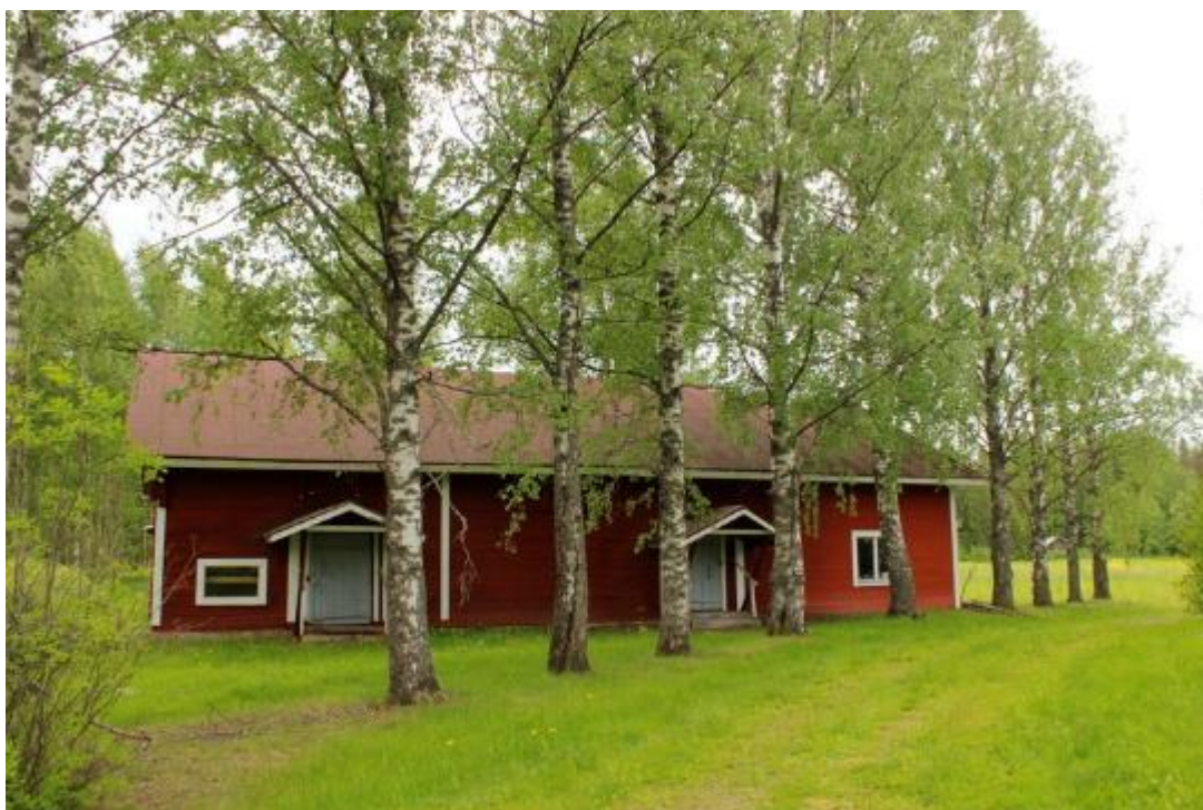
Kuva 61. Navetta ulkopuolelta kuvattuna. (Järvinen 2015.)
