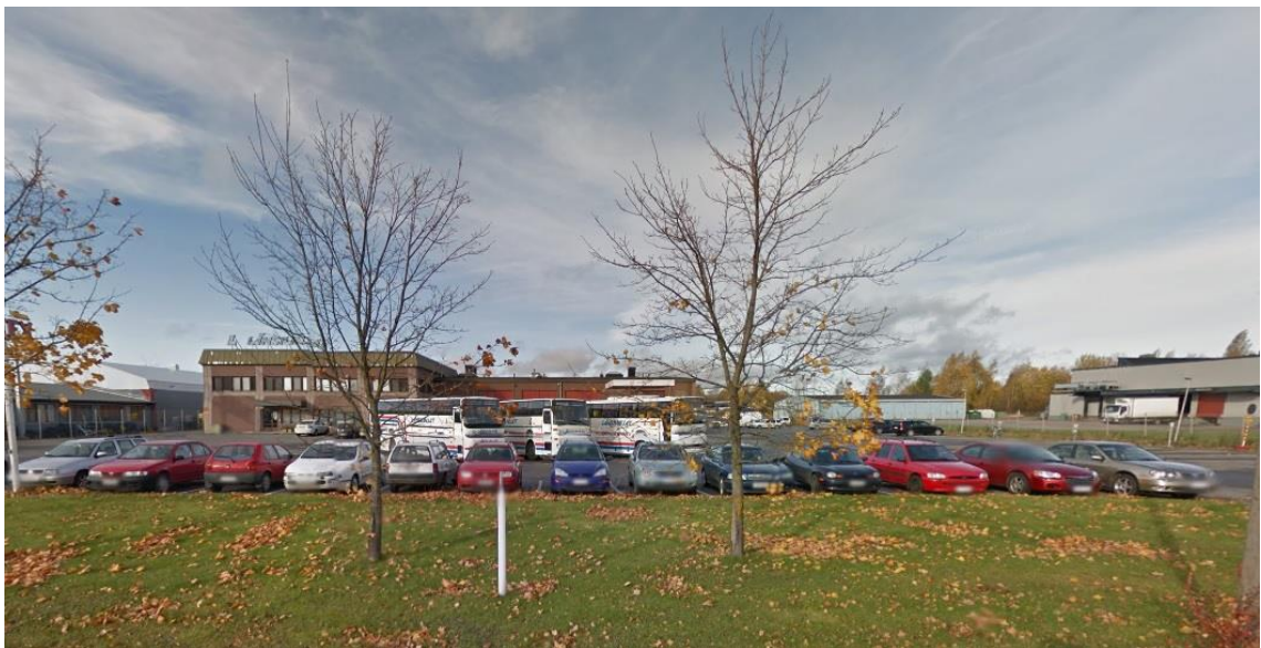
KUVA 1. Länsilinjojen toimipiste Sarankulmassa (Google Maps, 2011)
