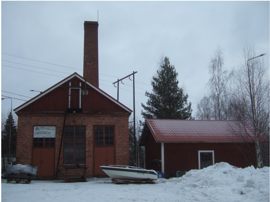
KUVA 1. Telakka alueen vanhin säilynyt rakennus on tiilinen voima-asema vuodelta 1915 (Pia Rask)
