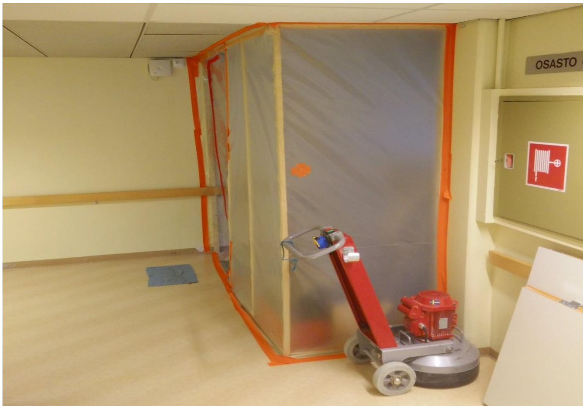
Kuva 1. Tiiviisti tehty sulkutila (Udd Erik 2015)
