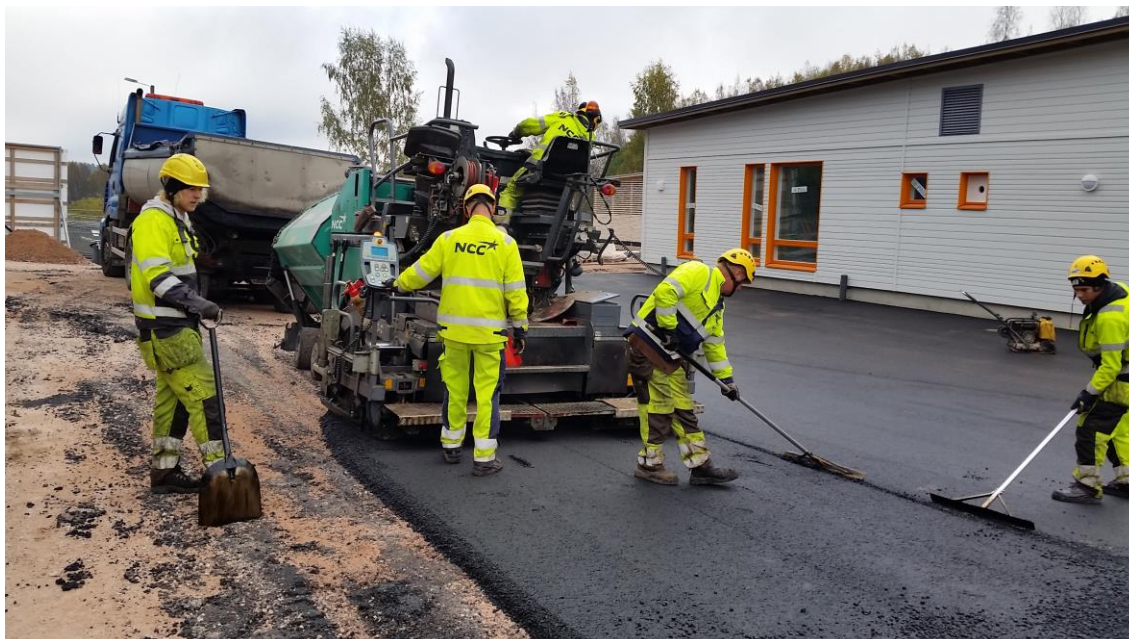
Kuva 5. Asfaltinlevitystyömaa.
