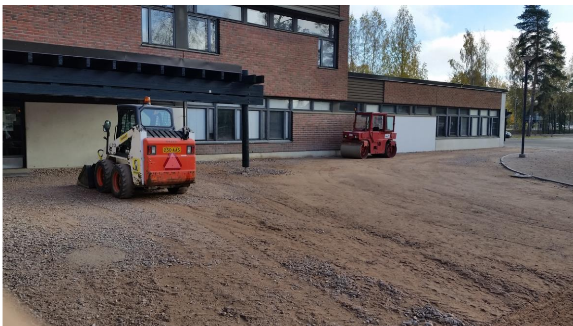
Kuva 7. Bobcat ja pikkujyrä
