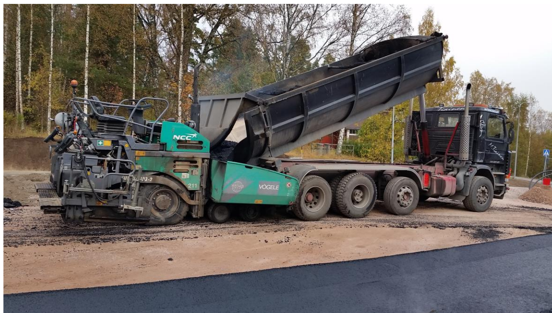
Kuva 4. Asfalttimassan siirtäminen levittäjään.
