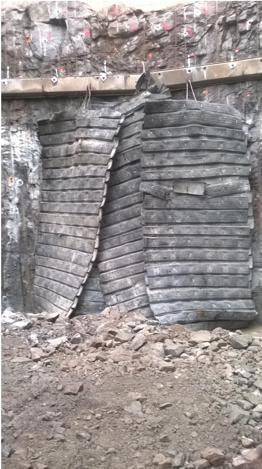
Kuva 10: Tunnelin avauksen peittämien tökkäysmatoilla.
