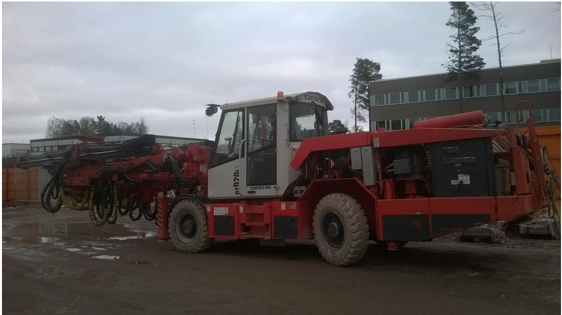
Kuva 1: Nykyaikainen kaksipuominen jumbo Destian urakoimalta Länsimetron ajotunnelityömaalta.
