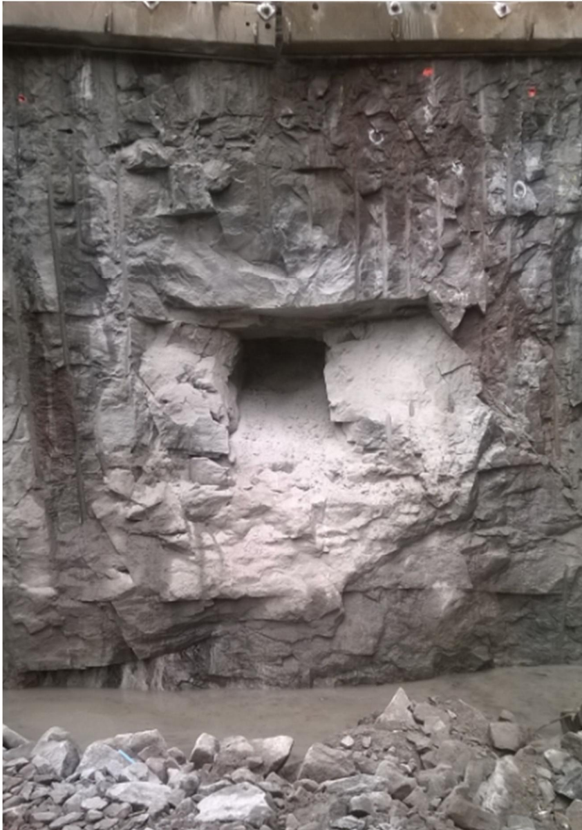
Kuva 11: Tunnelin avauksen ampuminen osissa ja lyhennetyllä katkolla. Kuvassa näkyy niin sanottu uuni.
