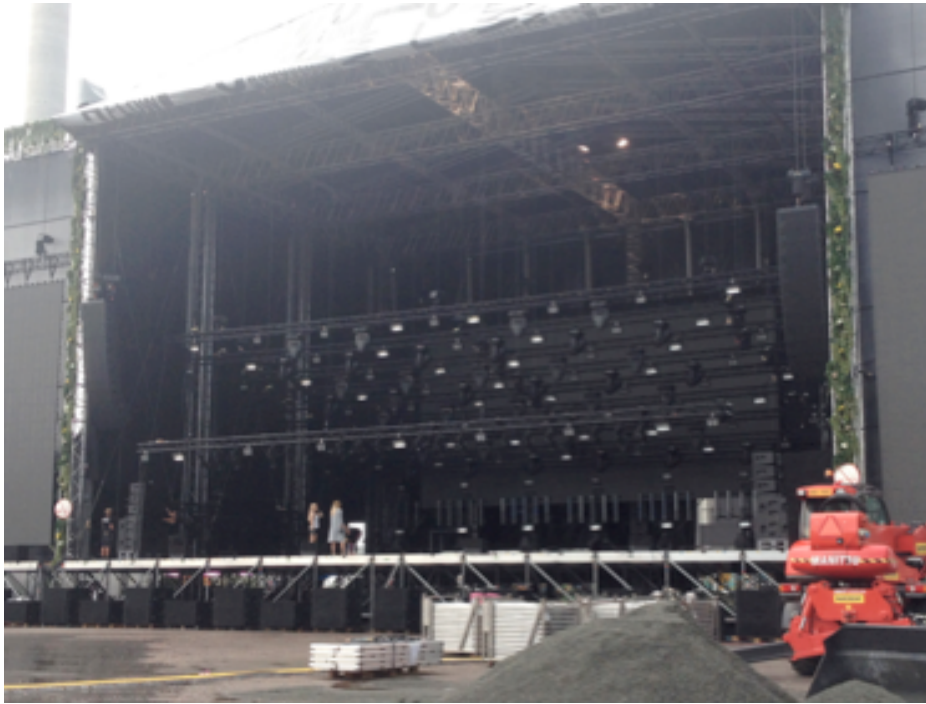
KUVA 17. Edellisen valokartan ripustukset rakenteilla Flow Festivaalin päälavalla (Kuva: Tiia Laajisto 2014)
